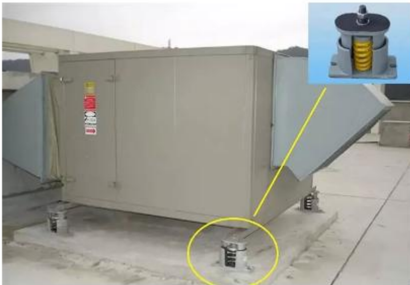
设备底部阻尼弹簧减震器设置
