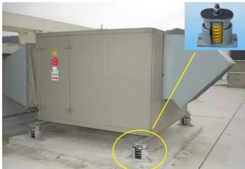
屋顶落地式风机安装示意图
