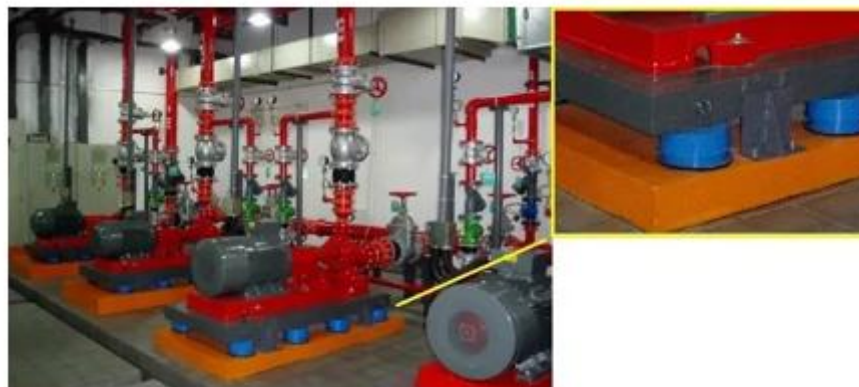
设备底部阻尼弹簧减震器设置
