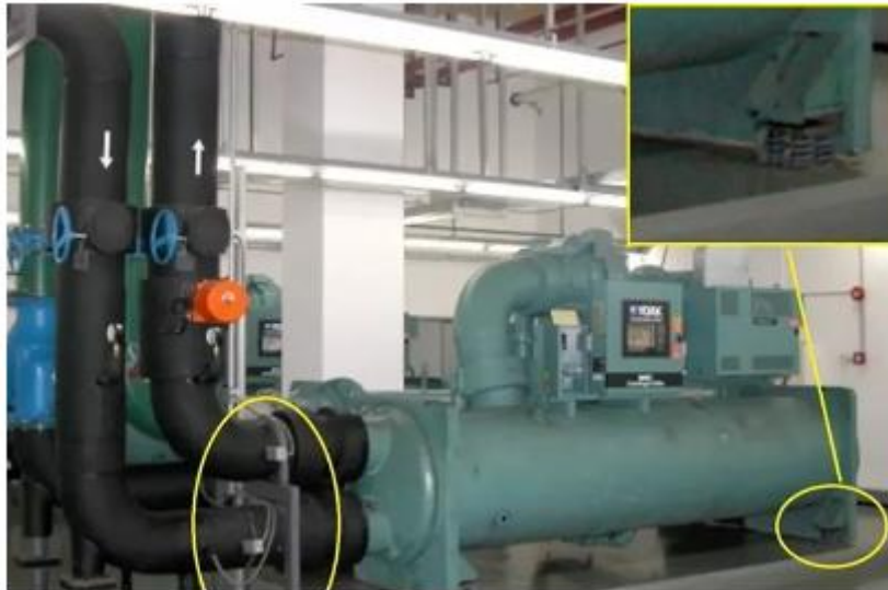
设备底部金属弹簧减振器设置
