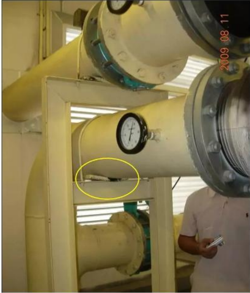
管道减振-橡胶减震垫
