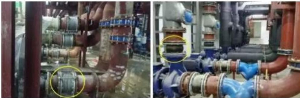
波纹补偿器和橡胶软接头
