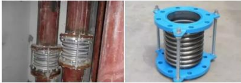
吊装式管道减振
