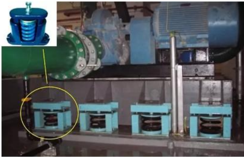
设备底部金属弹簧减振器设置
