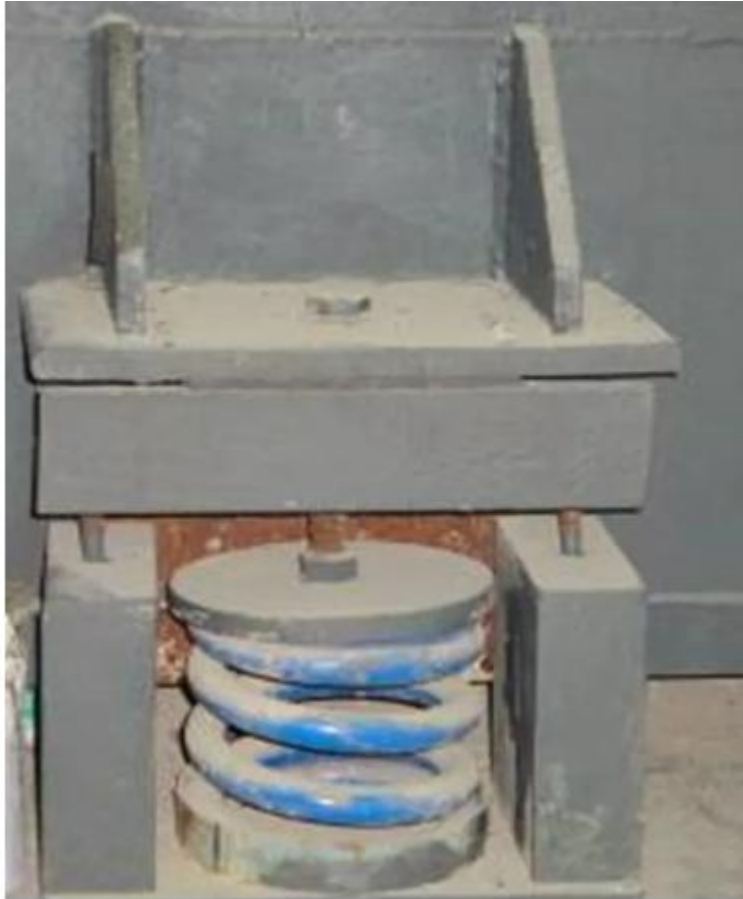
用混凝土制作水泵惯性块与减震器固定在一起
