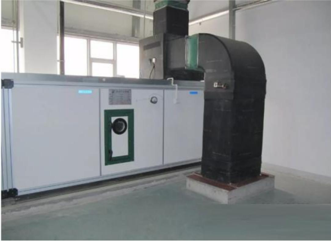
3)对有表冷器的空调机组，可由左向右或由右向左进行组装。表冷器段的凝结水的引流管应畅通，凝结水不得外溢，凝结水接头应安装水封，防止空调机组内空气外漏或室外空气进入空调机组内。
