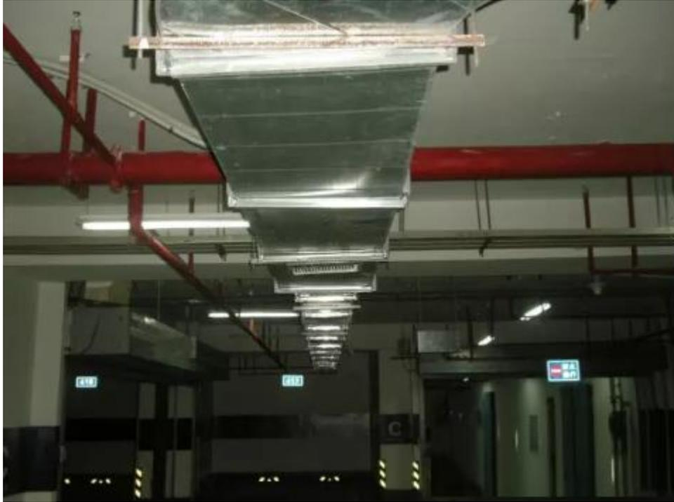
风管、电缆桥架、管道安装平直，标识清楚。
