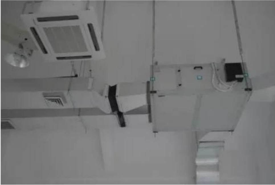
地下室通风管道安装平直，支吊架设置合理。
