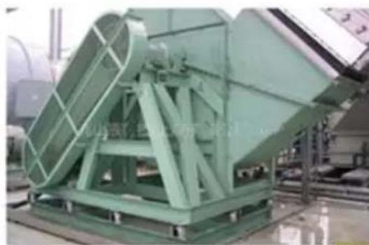
通风机安装在隔振台座上
