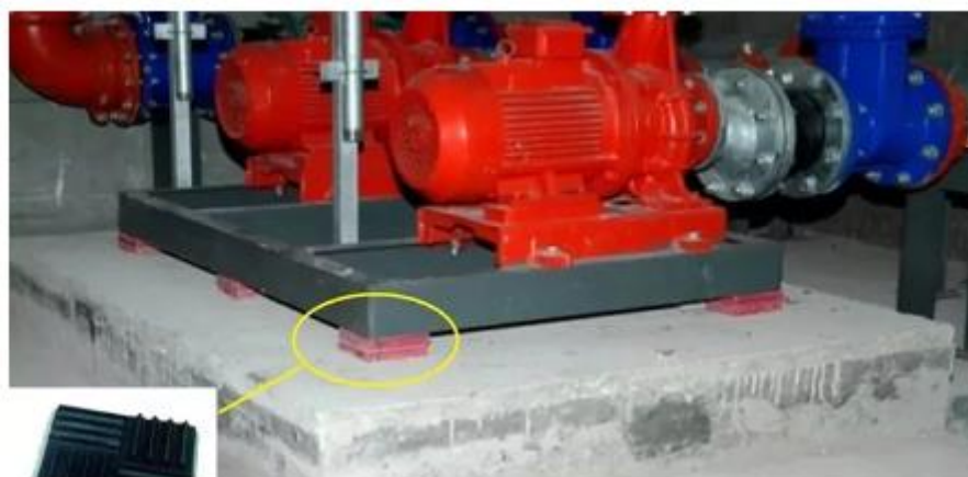
设备底部橡皮减震垫块设置
