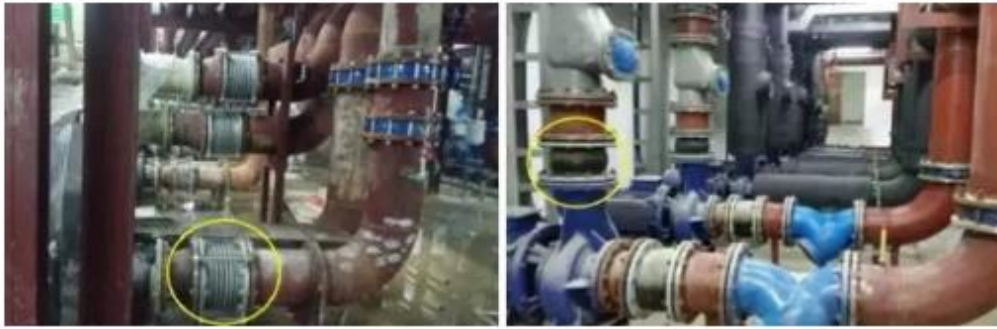
波纹补偿器和橡胶软接头
