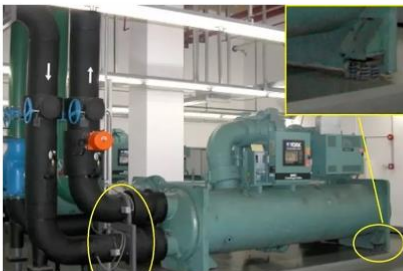
冷水机组底座设置弹簧减振器，落地支架应安装在柔性短管的后侧
