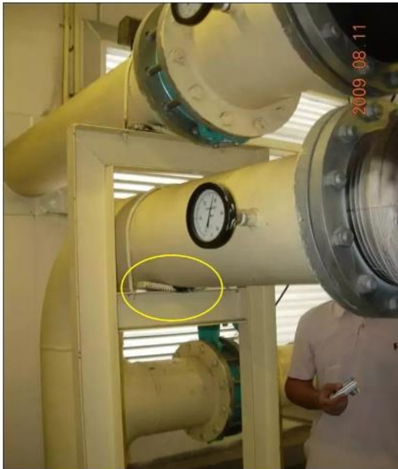
管道减振-橡胶减震垫
