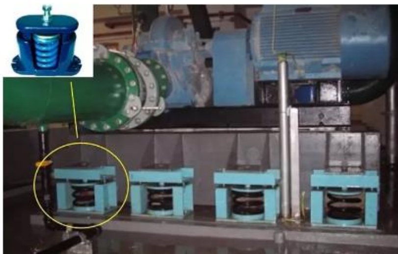
设备底部金属弹簧减振器设置
