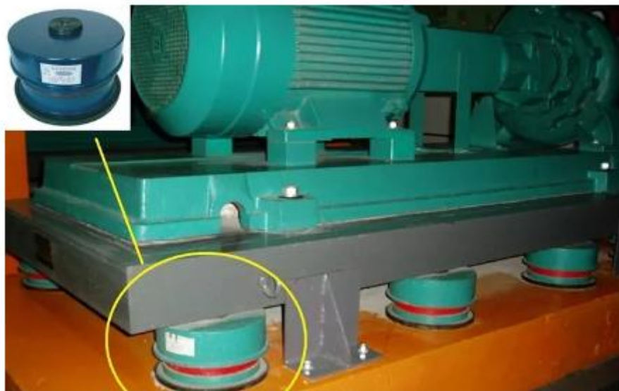
设备底部阻尼弹簧减震器设置
