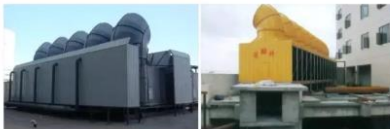
冷却塔消声处理
