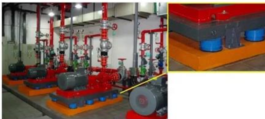
设置在设备底板两侧防位移的“靠山”
