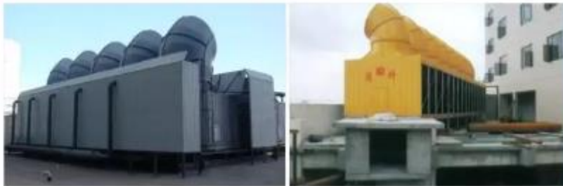
冷却塔消声处理
