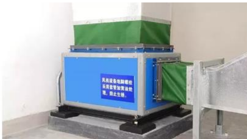
风管与风机应采用柔性短管连接
