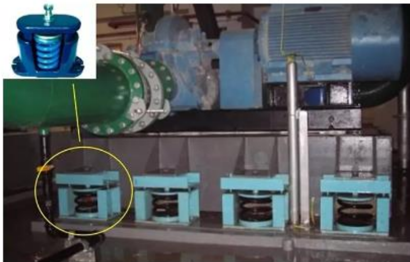
设备底部金属弹簧减振器设置
