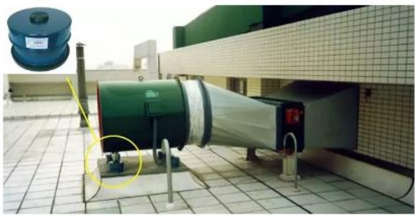
阻尼弹簧减震器
