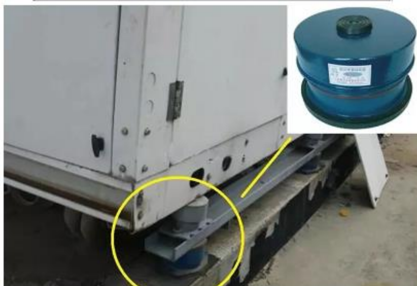
设备底部阻尼弹簧减震器设置
