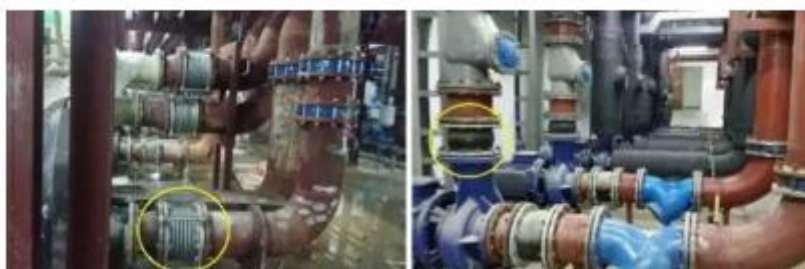
波纹补偿器和橡胶软接头
