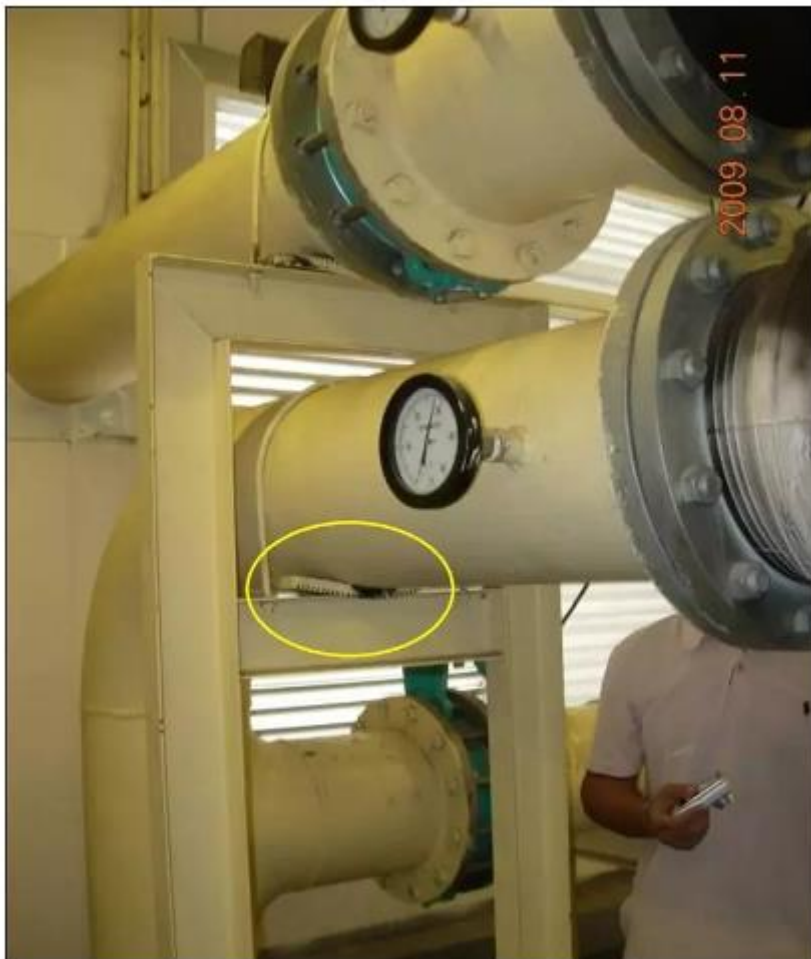
管道减振-橡胶减震垫
