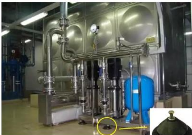
变频供水系统减振处理
