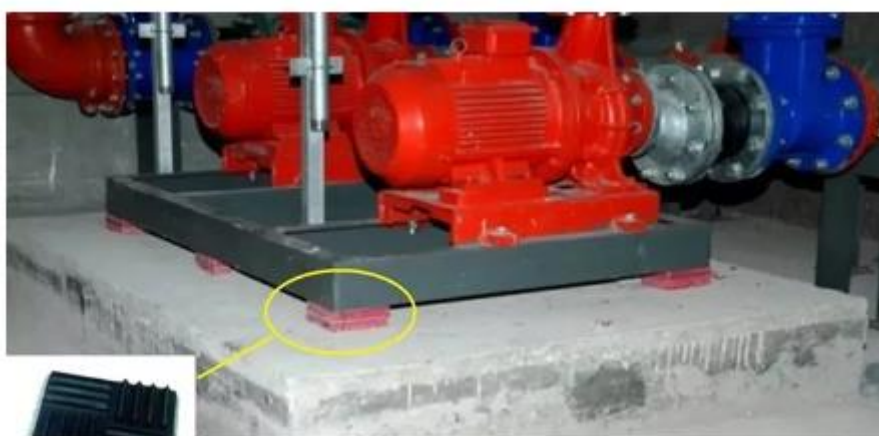
设备底部橡皮减震垫块设置
