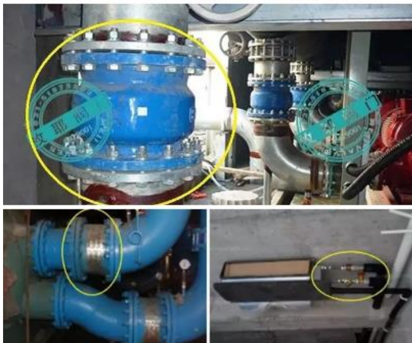
金属软接与金属软管
