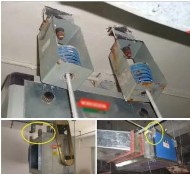
风机振动噪音处理
