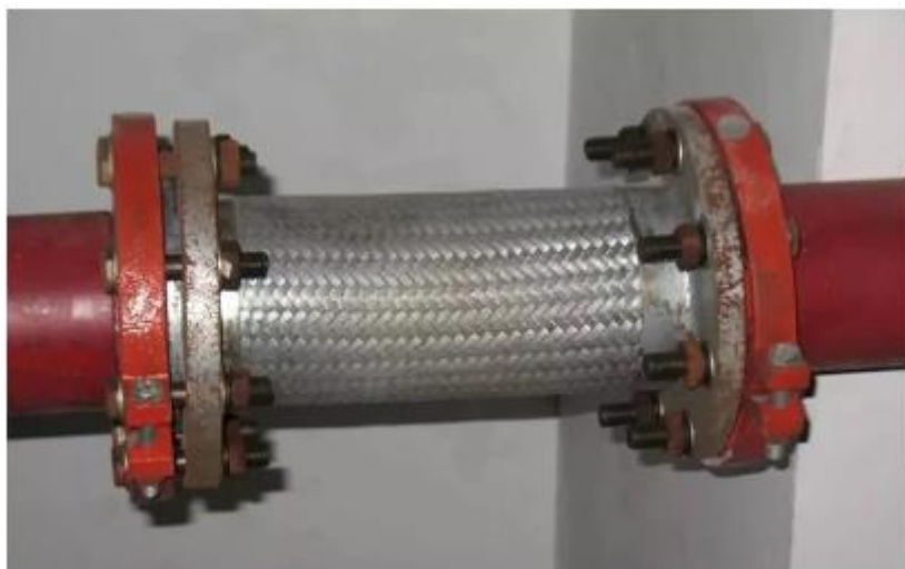
穿墙处金属软接
