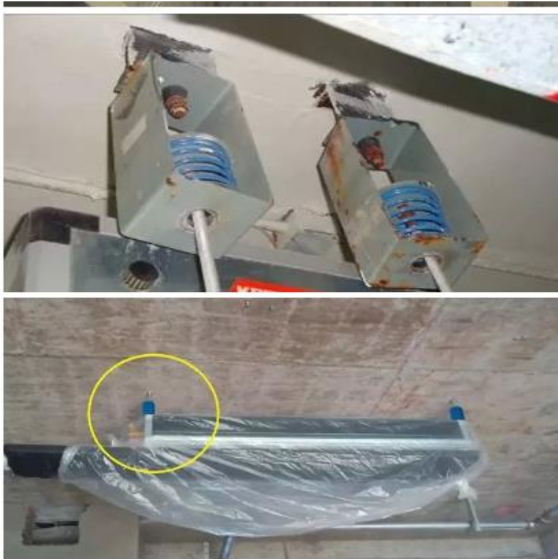
吊装式空调机组减振处理
