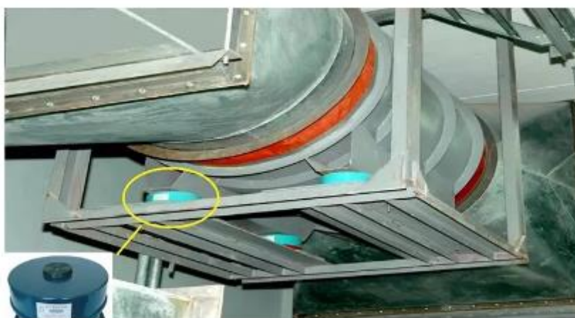
风机振动噪音处理
