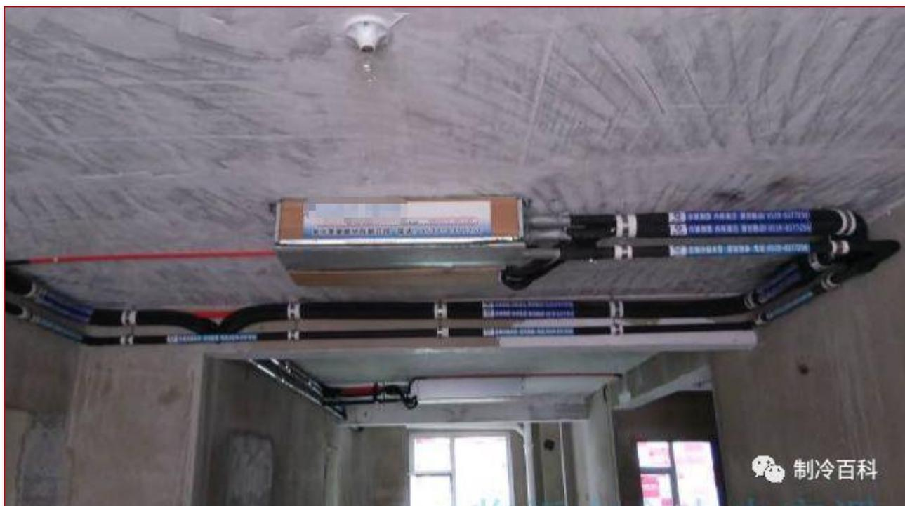
室内机水平安装 $\pm 1^\circ$  以内；室内机有足够的送回风空间；有足够的维修、保养空间；吊装室内机后应及时包裹保护；维修口应  $400 \times 400\text{mm}$  以上；
