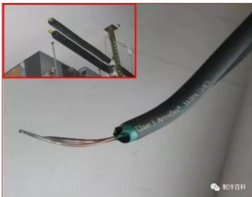
冷媒管在没有连接设备前应封口保护；三个月以上的冷媒管没有安装,应钎焊封口保护；
