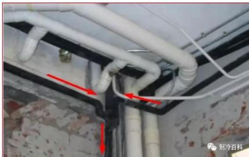
水平管接入立管, 应以一定的落差接入; 避免排水倒流;
