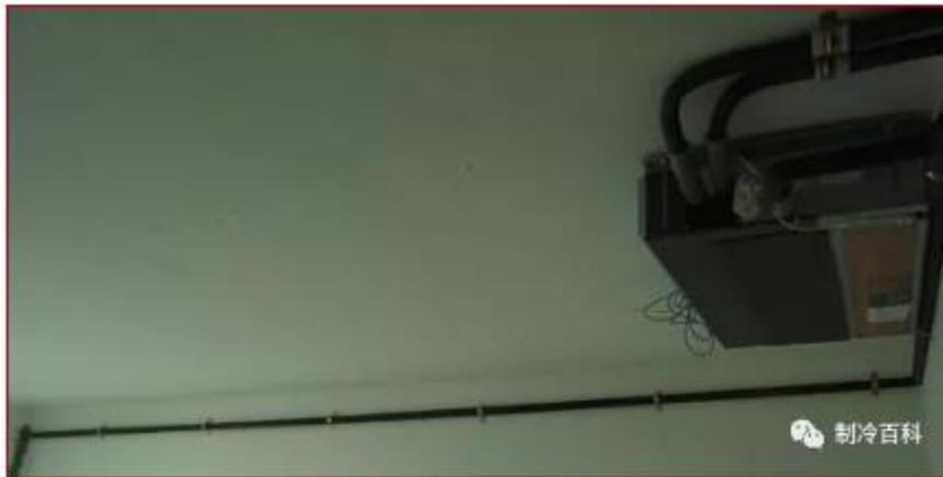
没有提升泵的室内机自然排水；随机排水软管应水平安装；保证以 1/100 以上的排水坡度进行排水；
