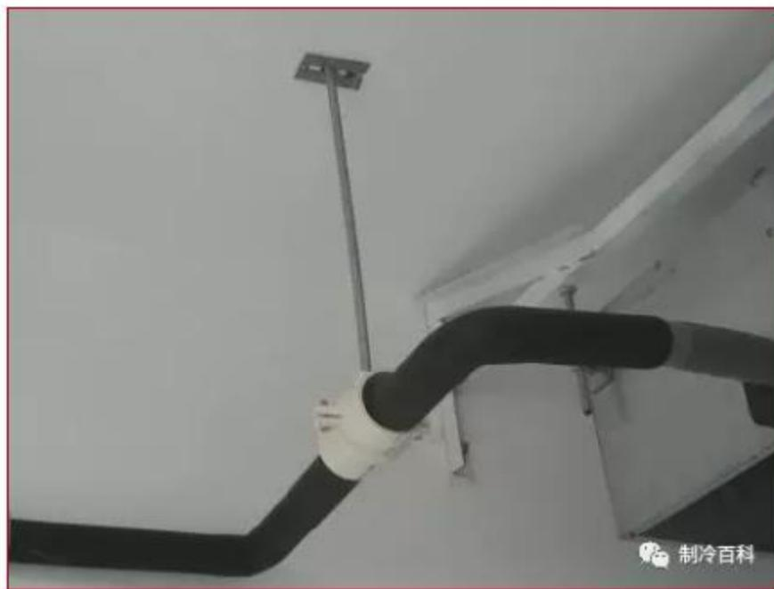
排水管与室内机连接 300~500mm 处应固定；
