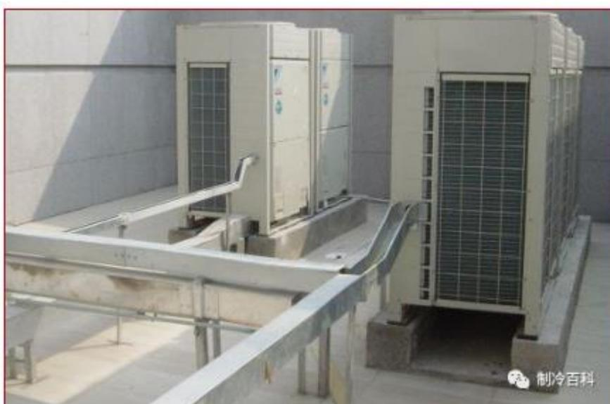
室外机水平安装 $\pm 1^\circ$  以内；室外机应保证足够的散热空间；室外机应有足够的维修空间；
