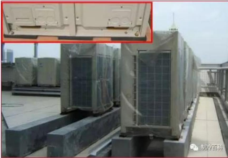
室外机基础高度 200mm 以上；防震垫厚度不小于 10mm；室外机安装位置便于排水。
