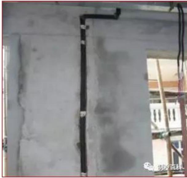
埋墙、埋地和室外冷凝排水管应做保温措施；埋墙的保温外表应用铁丝网保护后方可进行墙体修补；保温的粘接、修补须使用专用的胶水；
