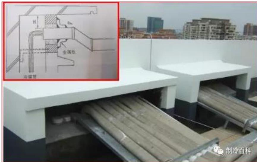
冷媒管穿越楼板, 应做好防水的施工工作; 冷媒管贯通后室外侧应有一定向下的坡度, 防止水回流;
