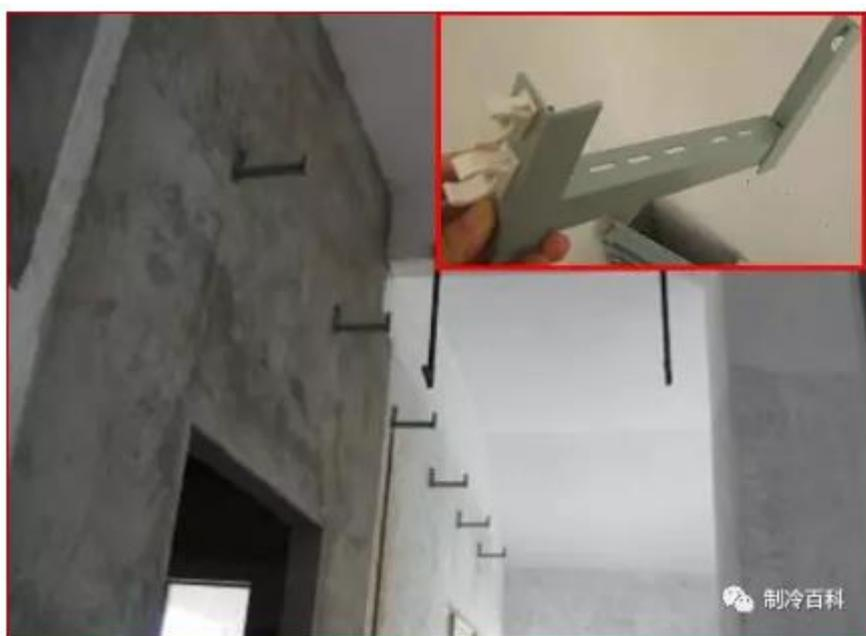
确定冷媒管、排水管的走向和定位；安装冷媒管、排水管前应先安装固定码；
