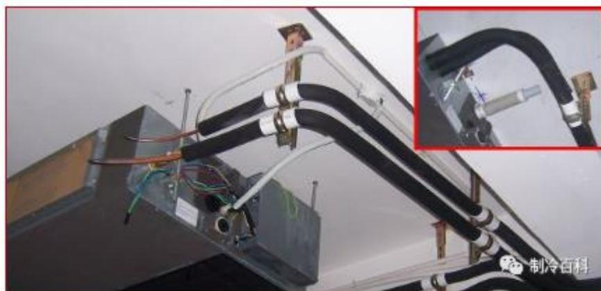
冷媒管与室内机连接 300~500mm 处应固定；室外冷媒管的 固定间隔应 1.2~1.5m/个；
