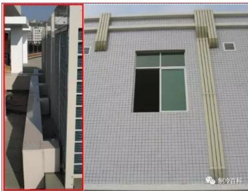
室外冷媒管应安装专用的 PVC 槽或管道槽进行保护；
