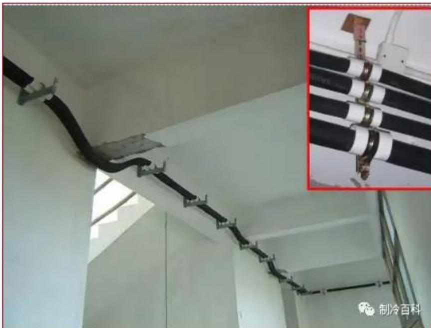
冷媒管、排水管的固定码间隔统一美观；冷媒管的固定间隔应 1.2~1.5m/个；
