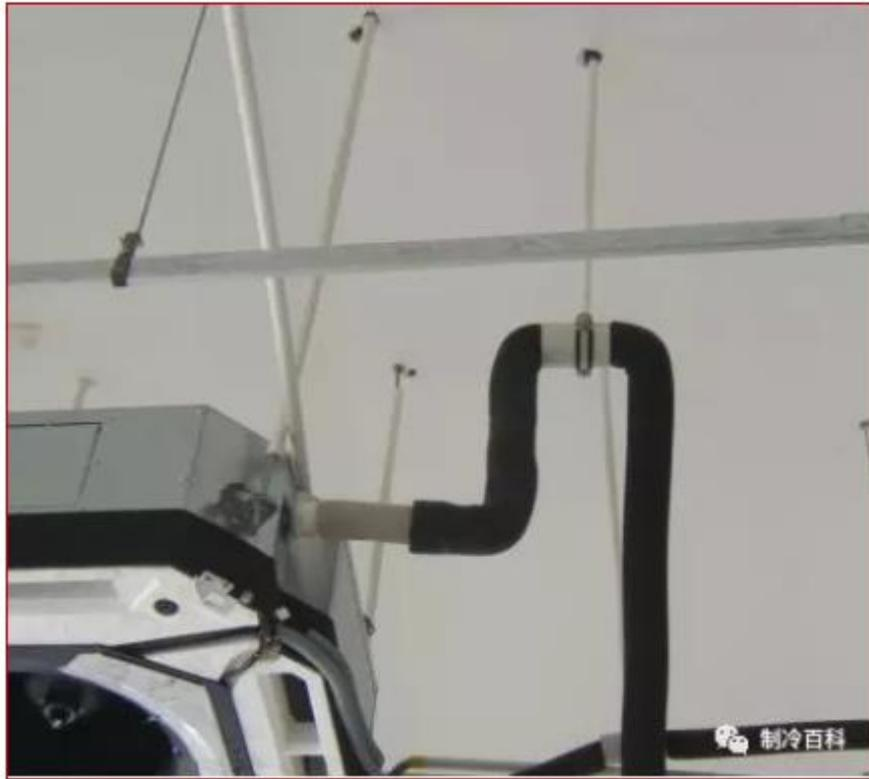
冷凝排水提升的横管段应固定；
