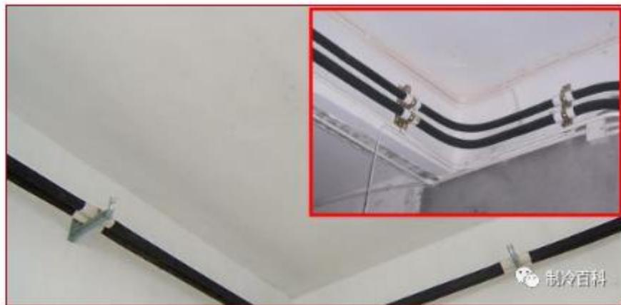
冷媒管转弯 300mm 处应固定；排水管的固定间距为 0.8~1.0m/个；排水管的转弯 300mm 处应固定；
