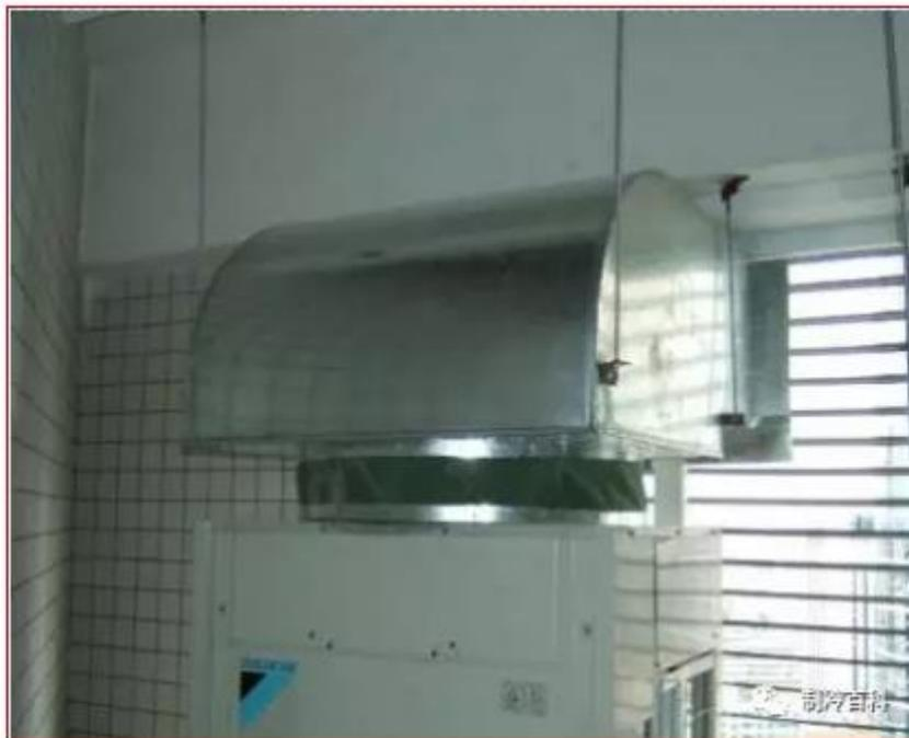
室外机分层摆放应安装排风导管；建筑百叶的导风角度应小于与水平夹角 20 度，百叶的通风率不小于 70%；
