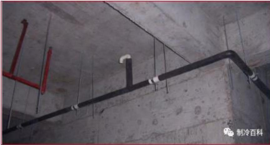
透气口应设置在冷凝排水主管的末端或中间位置；透气口应高于该系统中所有的室内机的排水位；透气口加弯头并管口朝下；
