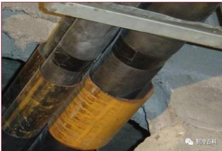
冷媒管或排水管穿墙加套管保护; 套管内的缝隙应用阻燃烧材料填满;
