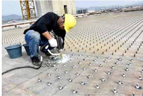
(b) 电弧螺柱焊焊接钢结构桥面板
