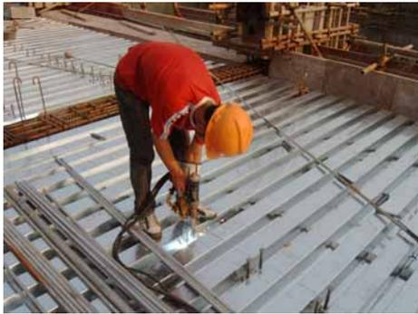
(a) 电弧螺柱焊焊接钢结构楼面压型板
