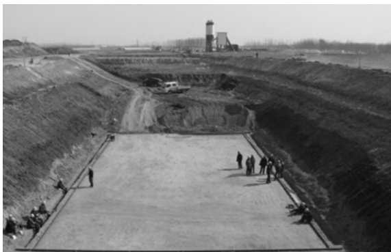
图 3-40 基坑开挖
