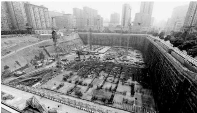
图 3-10 长沙国际金融中心筏板基础施工
