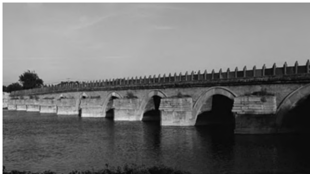
图3-1 著名的石拱桥——卢沟桥
