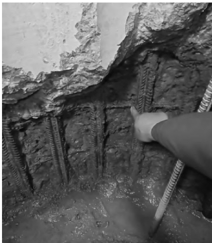
(a) 钻芯后灌注桩内灌注不密实
