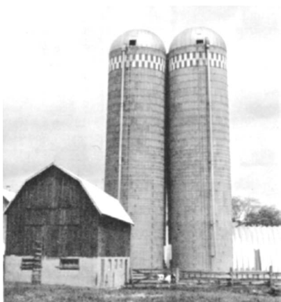
图 0-5 加拿大红河谷的两个饲料筒仓向内倾斜
