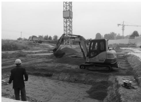
图 3-4 换填地基施工
