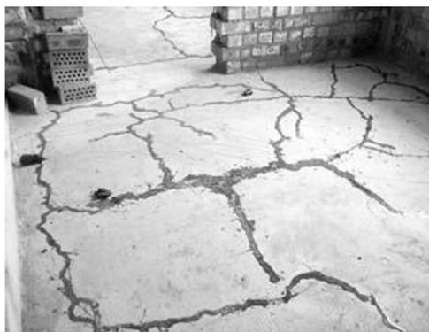
图 3-23 混凝土收缩裂缝
