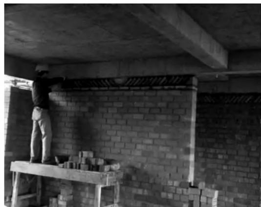
(b) 填充墙梁下口最后3皮砖砌筑
