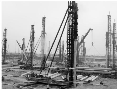
图3-11 锤击沉桩法施工
