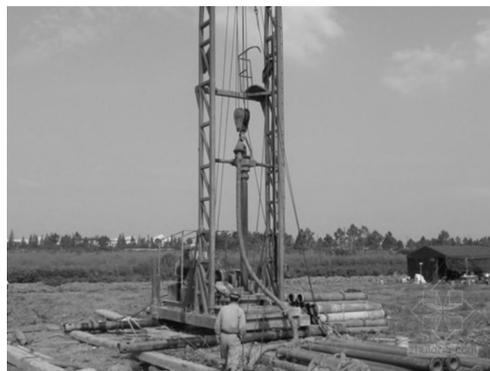
图3-8 泥浆护壁成孔灌注桩施工
