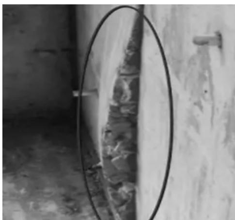
图 3-18 混凝土结构跑模、胀模后出现严重变形
