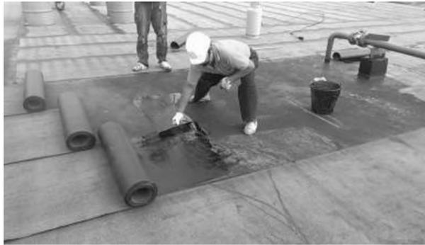
图 3-27 卷材防水层屋面施工
