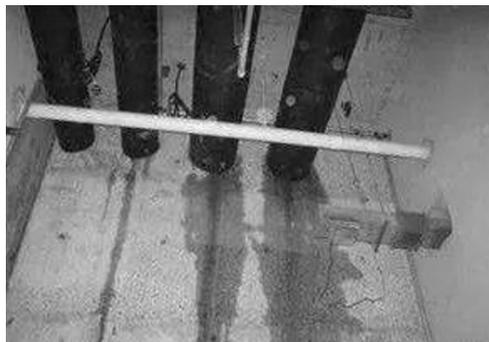
图 3-31 管道穿墙(地)部位渗漏水
