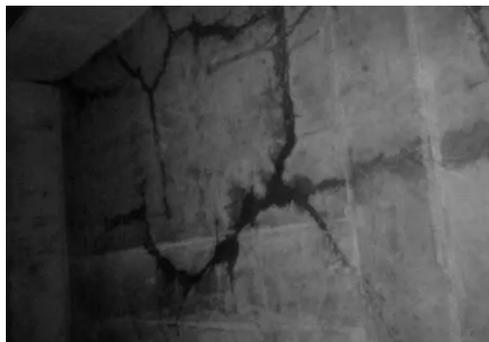
图 3-30 防水混凝土裂缝渗漏水
