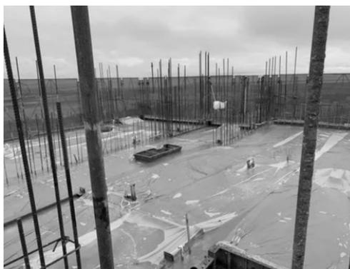
图 3-21 混凝土薄膜布养护
