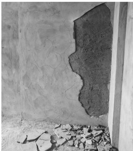
图 3-33 抹灰层呈空鼓、开裂状
