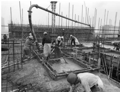
图 3-20 楼面浇筑混凝土
