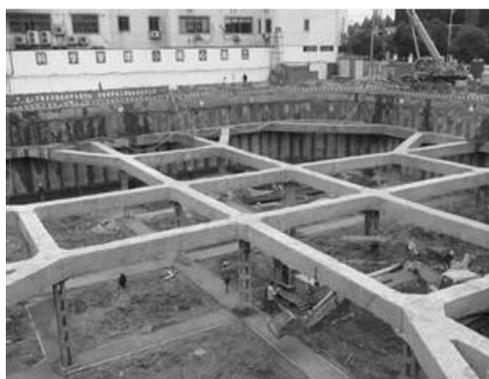
图3-2 深基坑土方开挖施工
