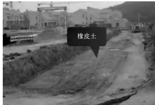
图 3-5 换土夯实中出现橡皮土
