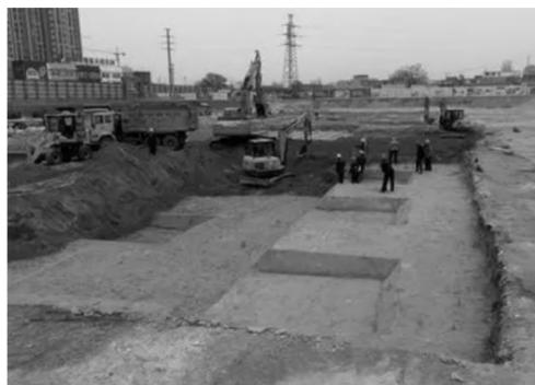
图3-1 浅基坑土方开挖施工
