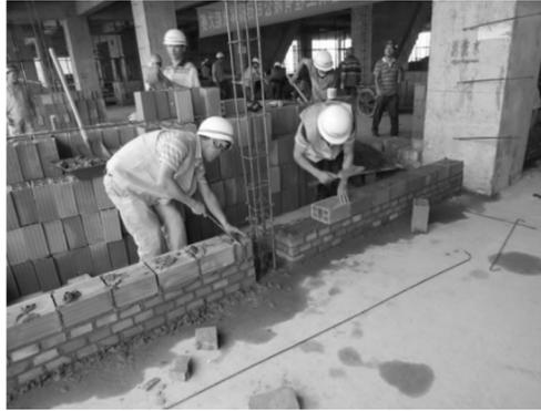
图3-24 填充墙砌体施工
