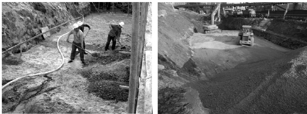
图 2-1 砂石地基施工现场
