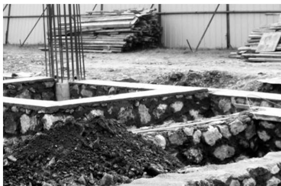
图 3-26 条形毛石基础
