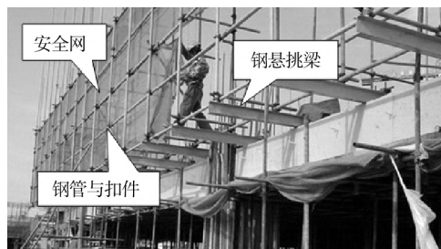
图 3-13 钢梁悬挑脚手架构件
