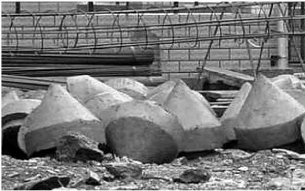
(b) 预制混凝土桩靴
