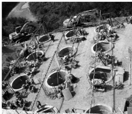
(b) 大直径群桩人工挖孔桩施工
