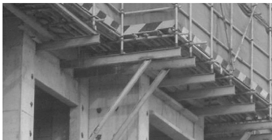
图 3-12 钢梁悬挑脚手架
