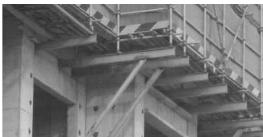
图 3-12 钢梁悬挑脚手架
