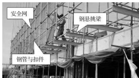
图 3-13 钢梁悬挑脚手架构件
