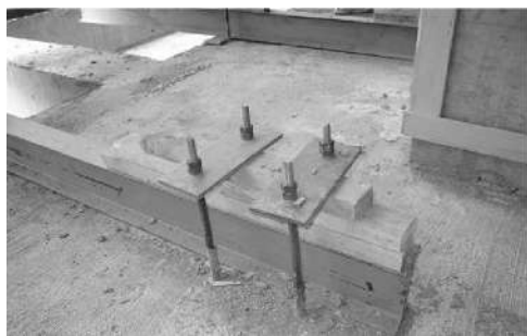
图 3-15 U 形螺栓构造
