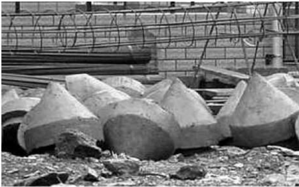
(b) 预制混凝土桩靴
