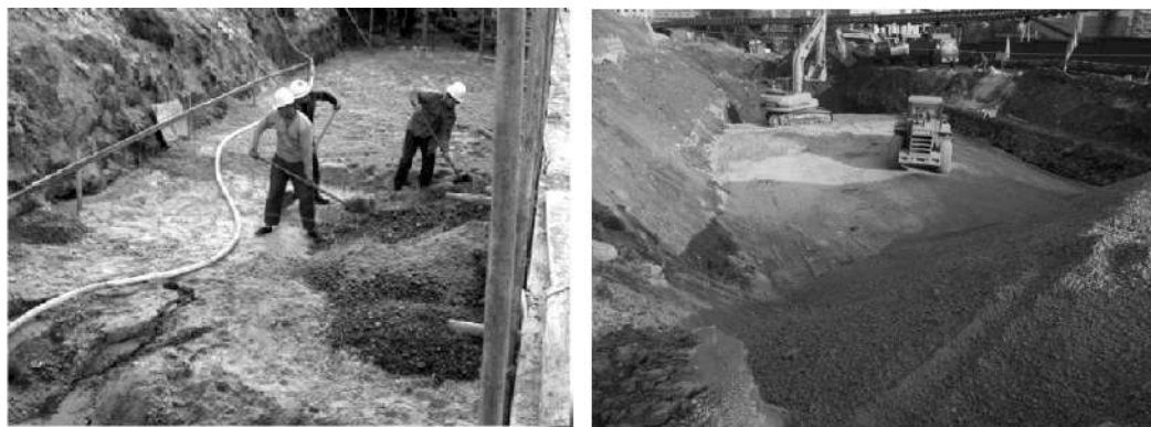
图 2-1 砂石地基施工现场
