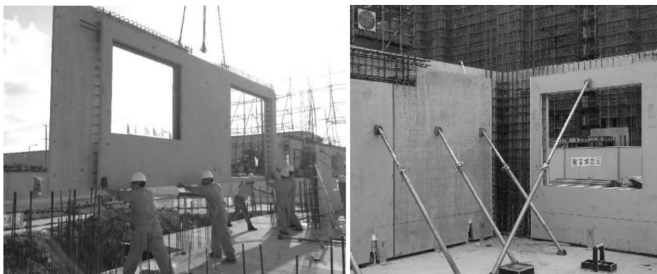
图 1-6 墙板吊装
