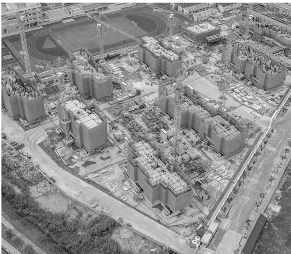
图 1-7 装配式施工现场整洁有序
