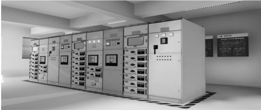
图 6-2 低压配电装置
