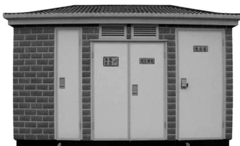
图 6-5 箱式变电所
