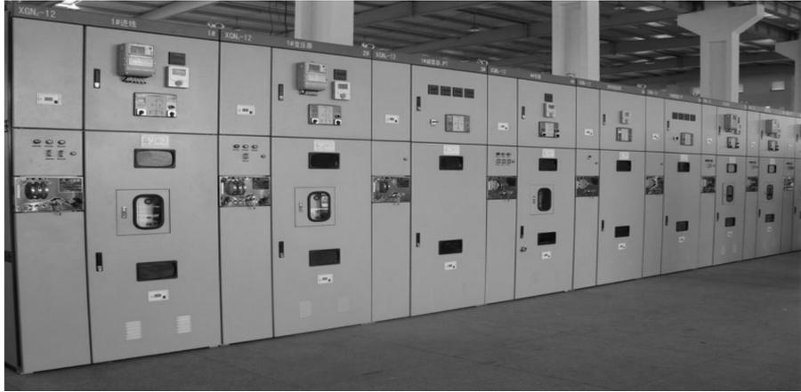
图 6-1 高压配电装置
