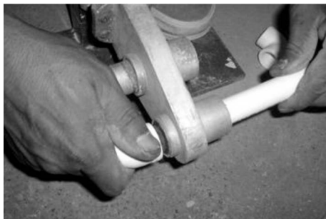
图 2-24 热熔连接
