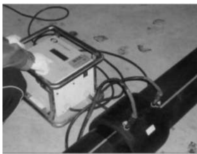
图 2-25 电熔连接
