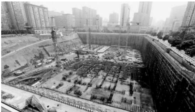
图 3-10 长沙国际金融中心筏板基础施工
