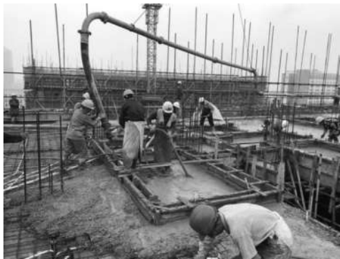
图 3-20 楼面浇筑混凝土
