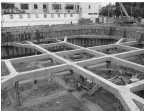
图3-2 深基坑土方开挖施工
