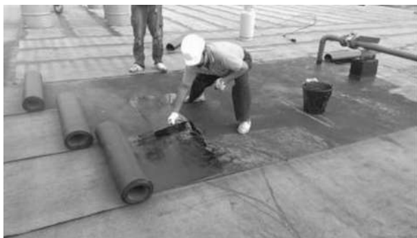
图 3-27 卷材防水层屋面施工
