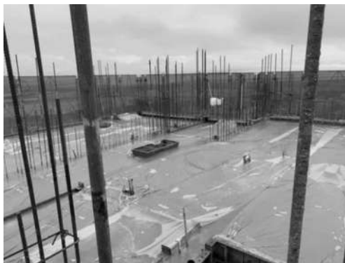
图 3-21 混凝土薄膜布养护
