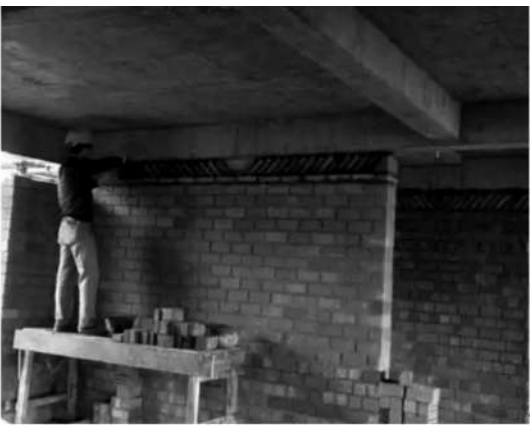
(b) 填充墙梁下口最后3皮砖砌筑
