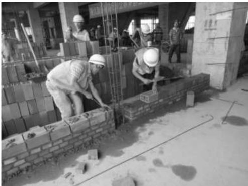
图 3-24 填充墙砌体施工
