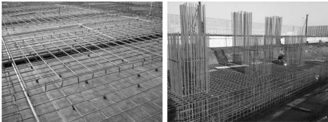
图 3-14 钢筋绑扎与安装
