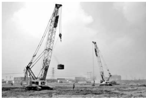
图 3-6 强夯地基施工
