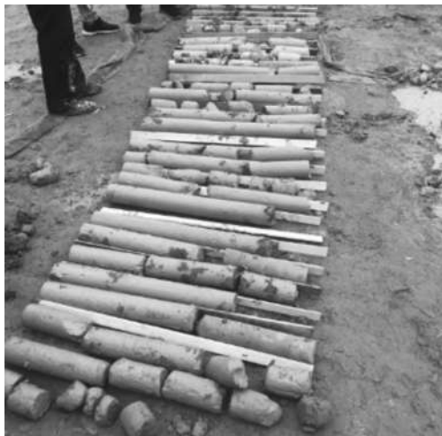
图 3-10 钻芯取样后灌注桩出现断桩
