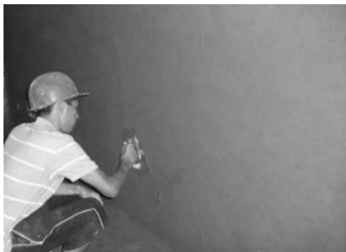
图3-32 一般抹灰施工
