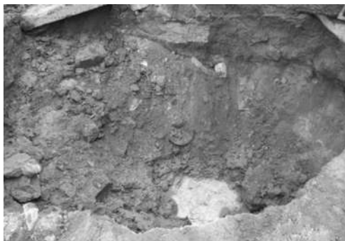
图 3-9 灌注桩坍孔
