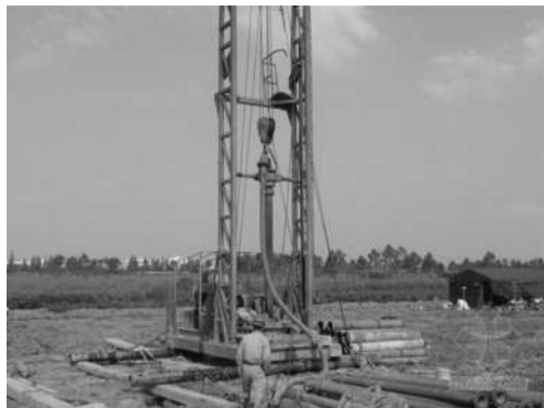
图3-8 泥浆护壁成孔灌注桩施工
