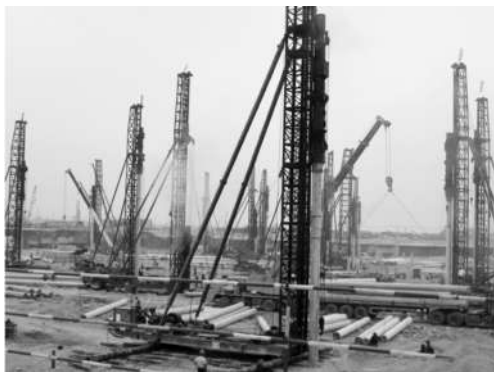
图 3-11 锤击沉桩法施工
