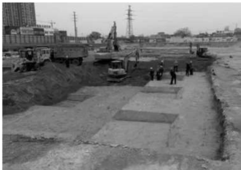
图3-1 浅基坑土方开挖施工
