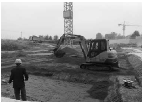
图 3-4 换填地基施工
