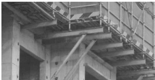
图 3-12 钢梁悬挑脚手架
