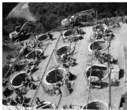
(b) 大直径群桩人工挖孔桩施工
