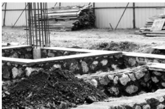
图 3-26 条形毛石基础
