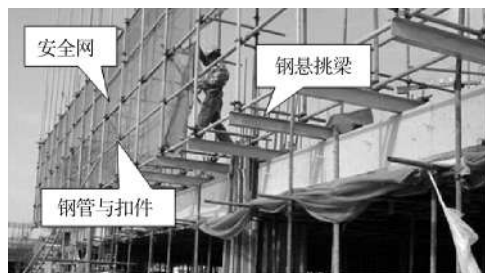
图 3-13 钢梁悬挑脚手架构件
