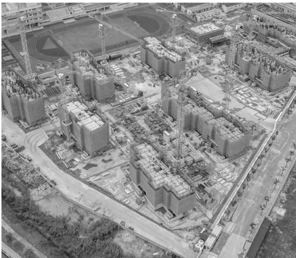
图 1-7 装配式施工现场整洁有序
