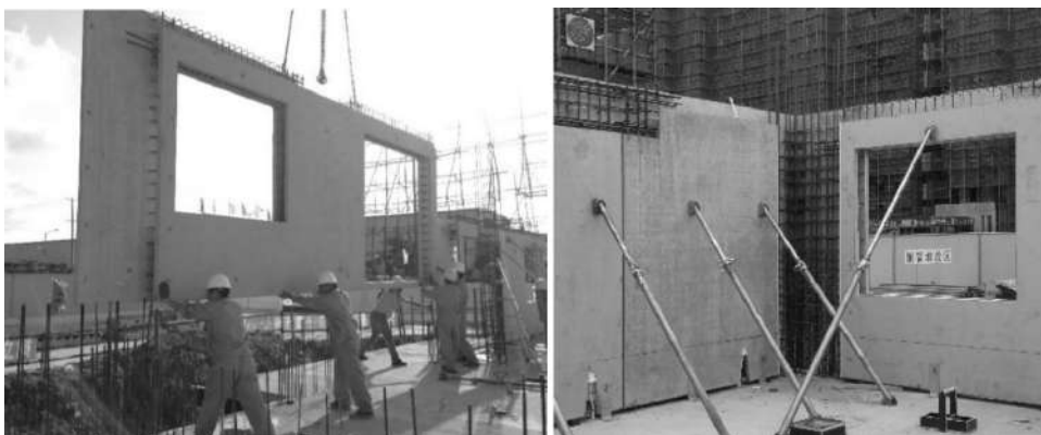
图 1-6 墙板吊装
