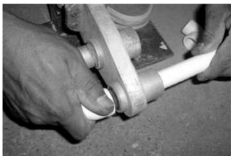
图 2-24 热熔连接
