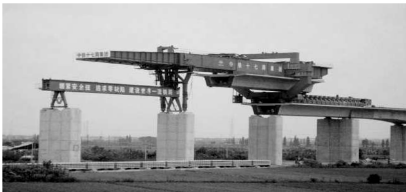
图 2-6 预制安装施工法
