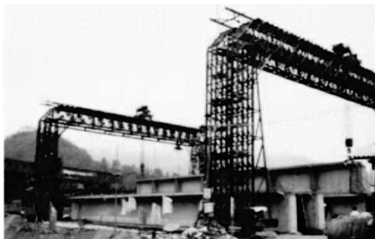
图 3-4 贝雷梁拼装的龙门吊
