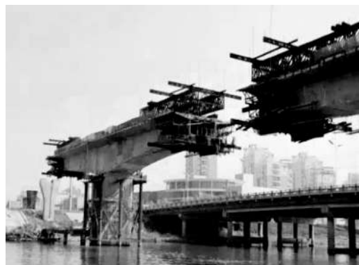
图 2-9 悬臂浇筑施工法
