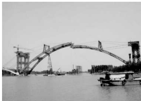
图 2-10 竖转施工法
