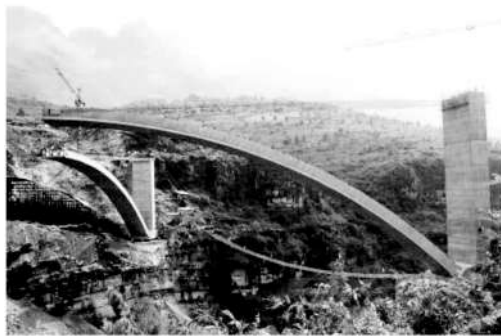
图 2-11 平转施工法
