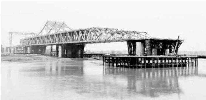
图 2-12 顶推施工法
