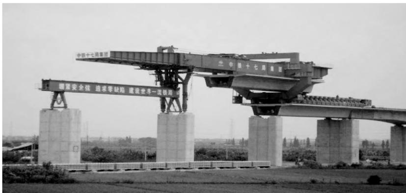
图 2-6 预制安装施工法
