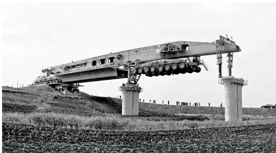
图 3-31 吊运架一体式架桥机架梁
