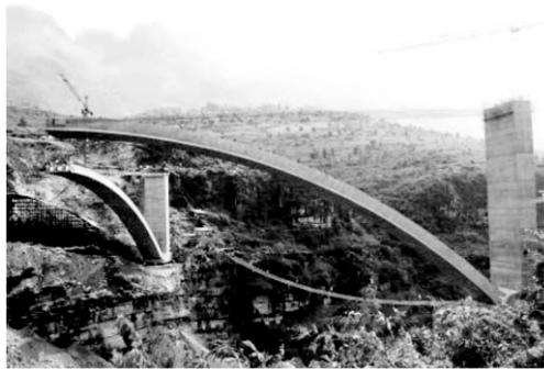
图 2-11 平转施工法
