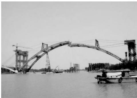
图 2-10 竖转施工法
