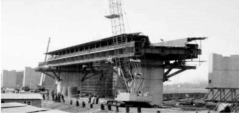
图 2-7 移动模架施工法
