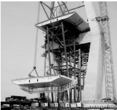
图 2-8 悬臂拼装施工法
