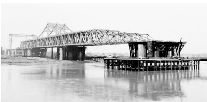
图 2-12 顶推施工法
