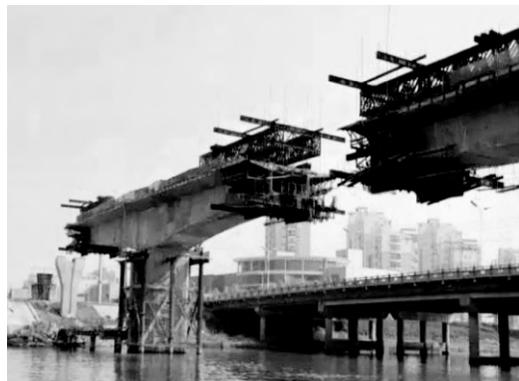
图 2-9 悬臂浇筑施工法
