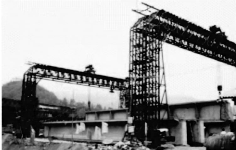
图 3-4 贝雷梁拼装的龙门吊
