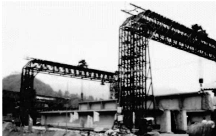
图 3-4 贝雷梁拼装的龙门吊
