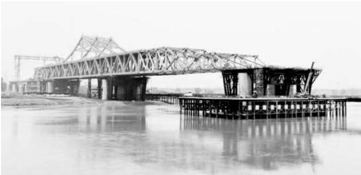
图 2-12 顶推施工法
