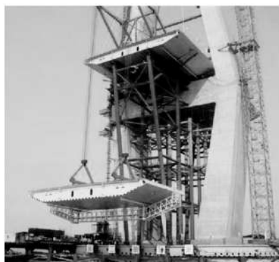
图 2-8 悬臂拼装施工法
