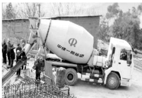
图 3-20 混凝土搅拌运输车
