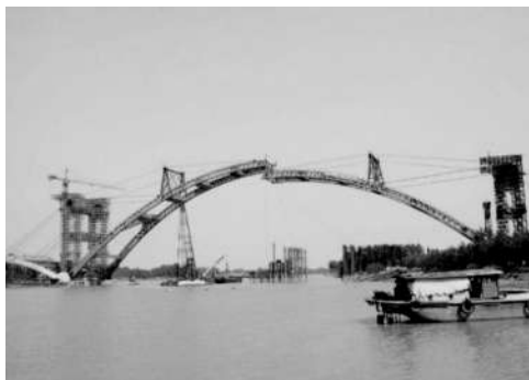
图 2-10 竖转施工法
