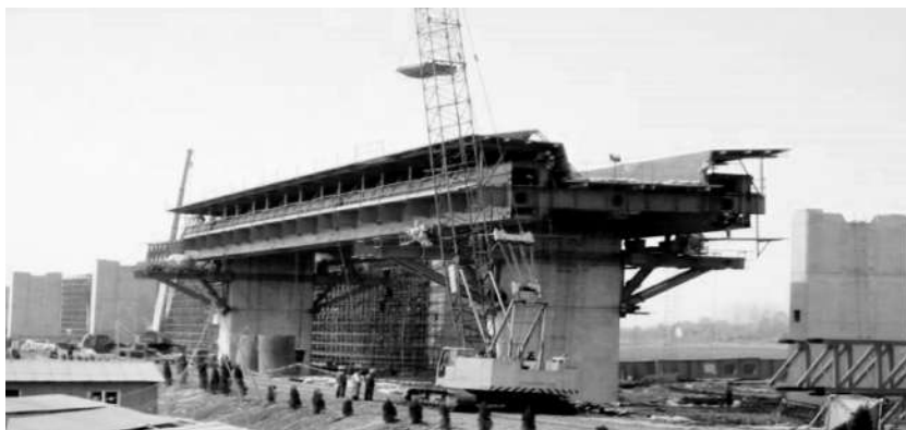
图 2-7 移动模架施工法
