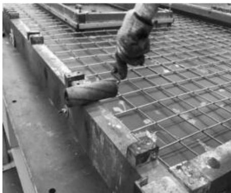
图3-40 外模挡边涂脱模剂
