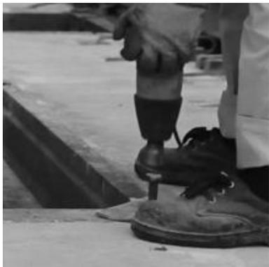
图 3-53 拆门窗洞螺栓
