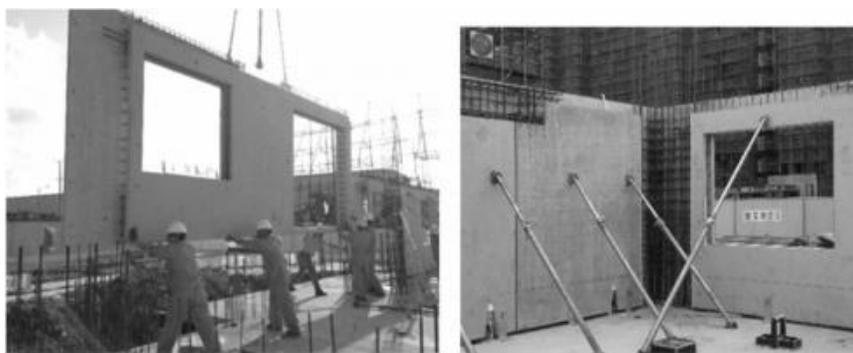
图 1-20 装配化施工现场——墙板吊装
