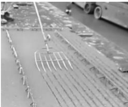
图 3-52 楼板后处理工序
