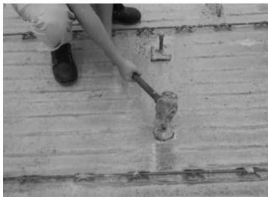
图 3-56 预埋件拆除
