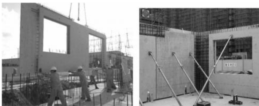
图 1-20 装配化施工现场——墙板吊装
