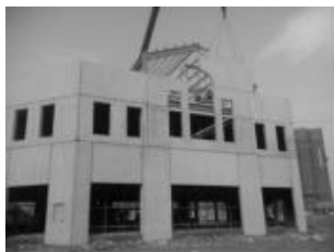
(a) 装配式混凝土结构
