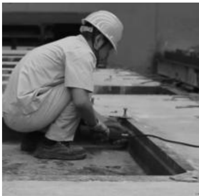
图 3-54 拆压铁
