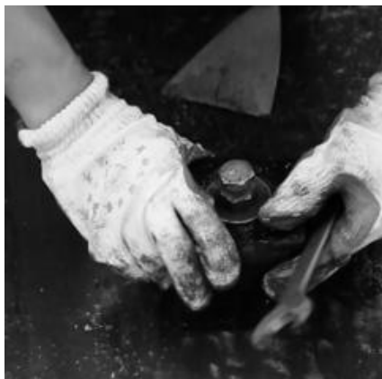
图 3-47 楼板预埋件安装
