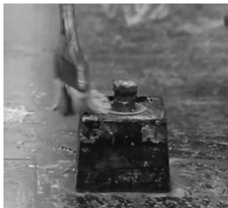
图 3-42 楼板预埋件涂脱模剂
