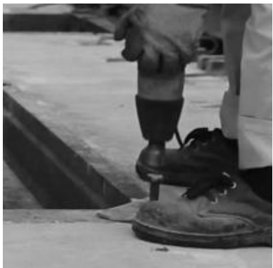
图 3-53 拆门窗洞螺栓
