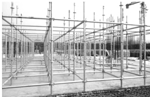
图 3-13 盘扣式支撑体系应用案例
