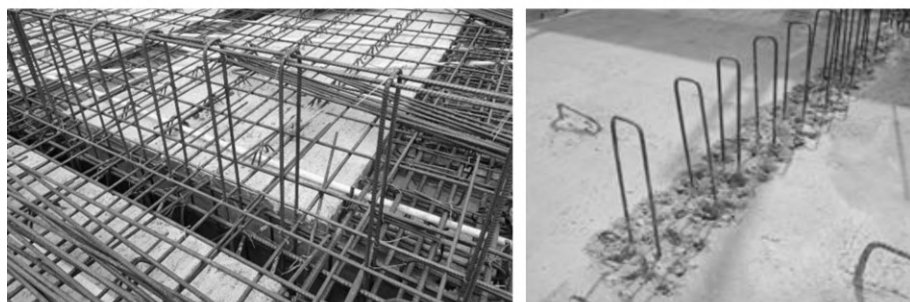
(b) 竖向连接钢筋安装预埋
