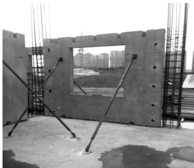
图 3-6 自攻钉式斜支撑
