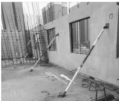
图 3-5 带拉钩的斜支撑
