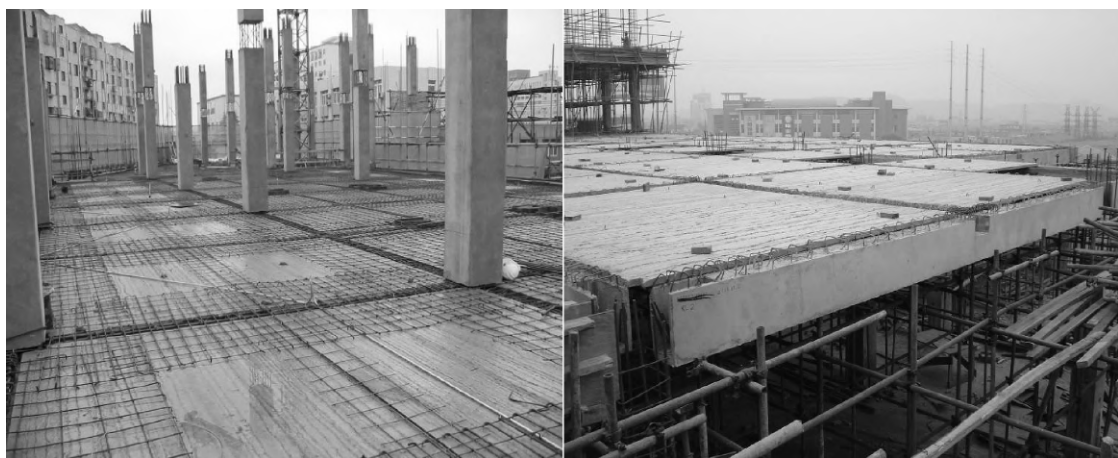
图 1-5 装配整体式框架结构施工现场
