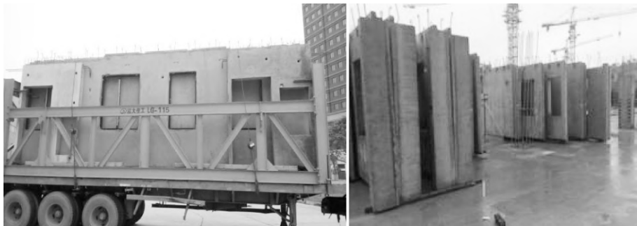
图 2-14 施工现场预制墙板存放
