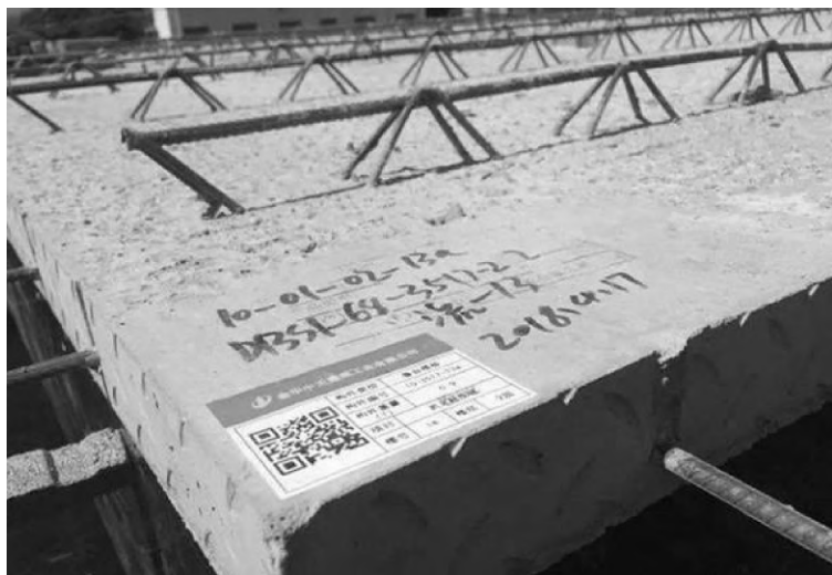
图 2-13 预制构件标识
