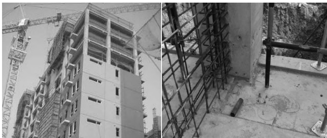
图 1-8 装配整体式框架-现浇剪力墙结构施工现场
