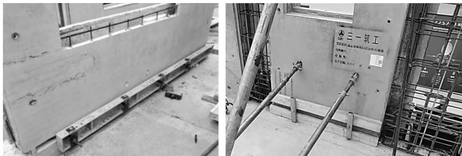
图 3-49 水平接缝封堵图
