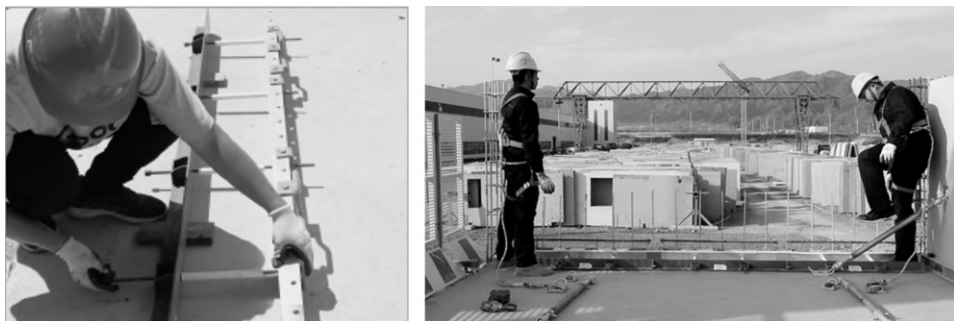
图 3-41 底部工装安装
