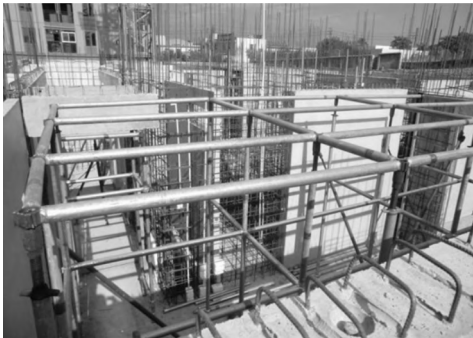
图 3-15 键槽式支撑体系应用案例
