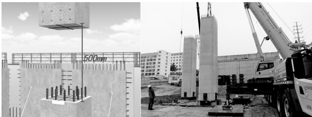
图 3-20 预制框架柱吊装示意图
