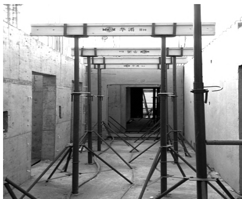
图 3-10 独立三脚架支撑体系应用案例
