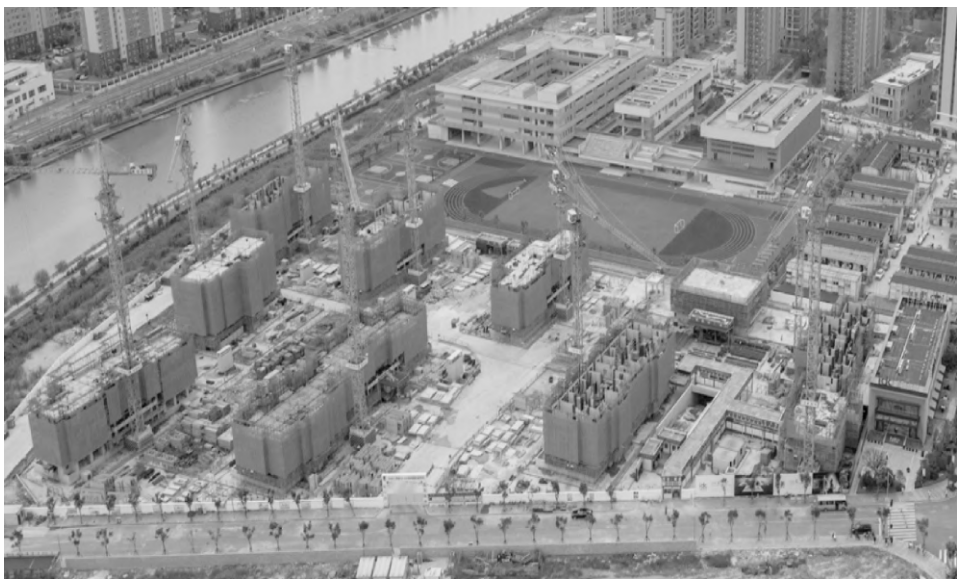
图 3-3 某项目施工现场平面布置实景
