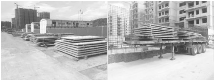
图 2-15 施工现场叠合楼板存放
