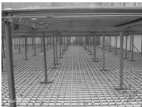
图 3-13 马凳筋实物图
