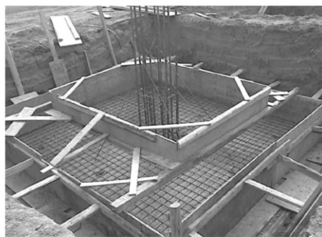
(b) 独立基础底筋实物图
