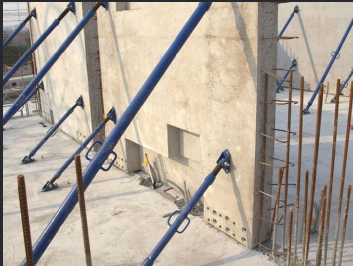
装配整体式套筒剪力墙结构
