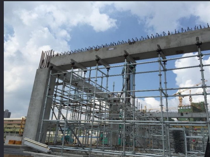
装配整体式预制预应力框架结构
