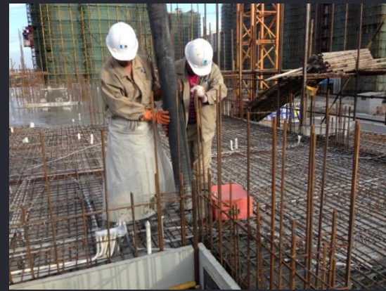
8 浇筑混凝土 0.5天
