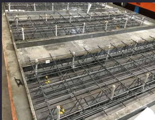
5 钢筋绑扎、埋件放置
