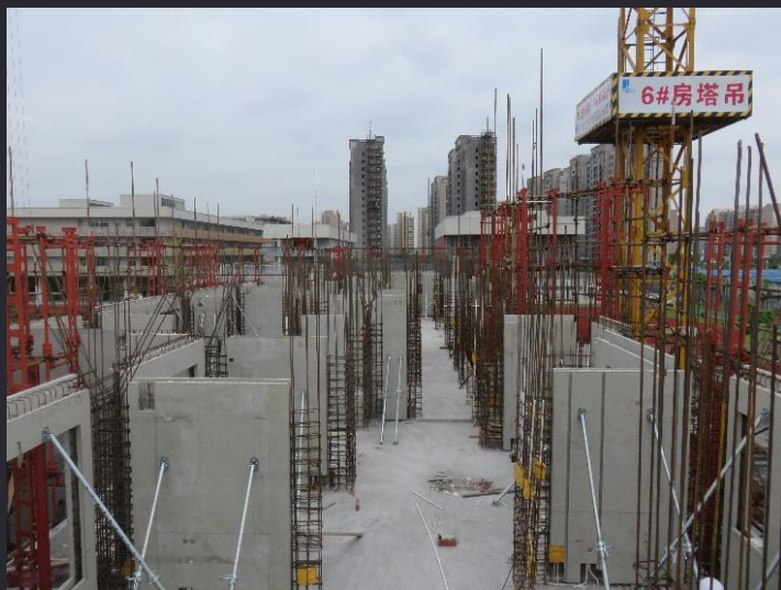
叠合板式混凝土剪力墙结构
