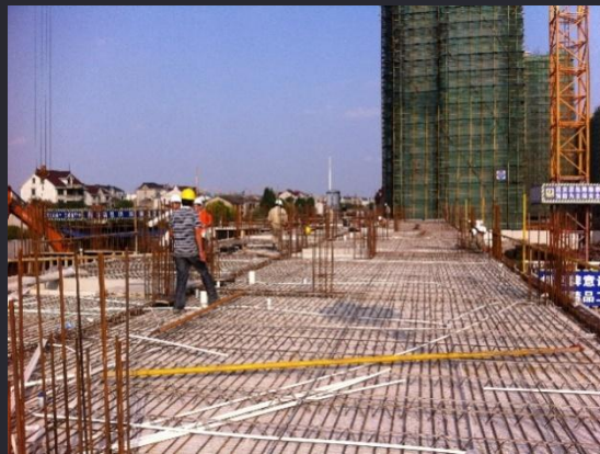
7 钢筋、管线铺设 0.5天
