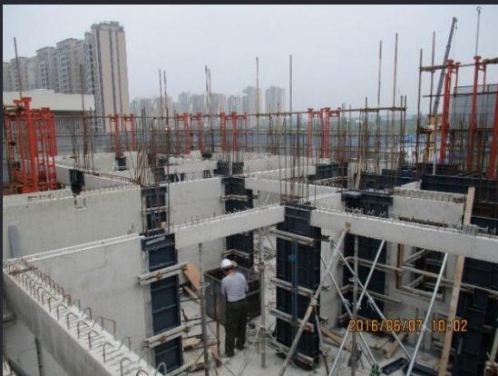
5 工具化模板安装 1天
