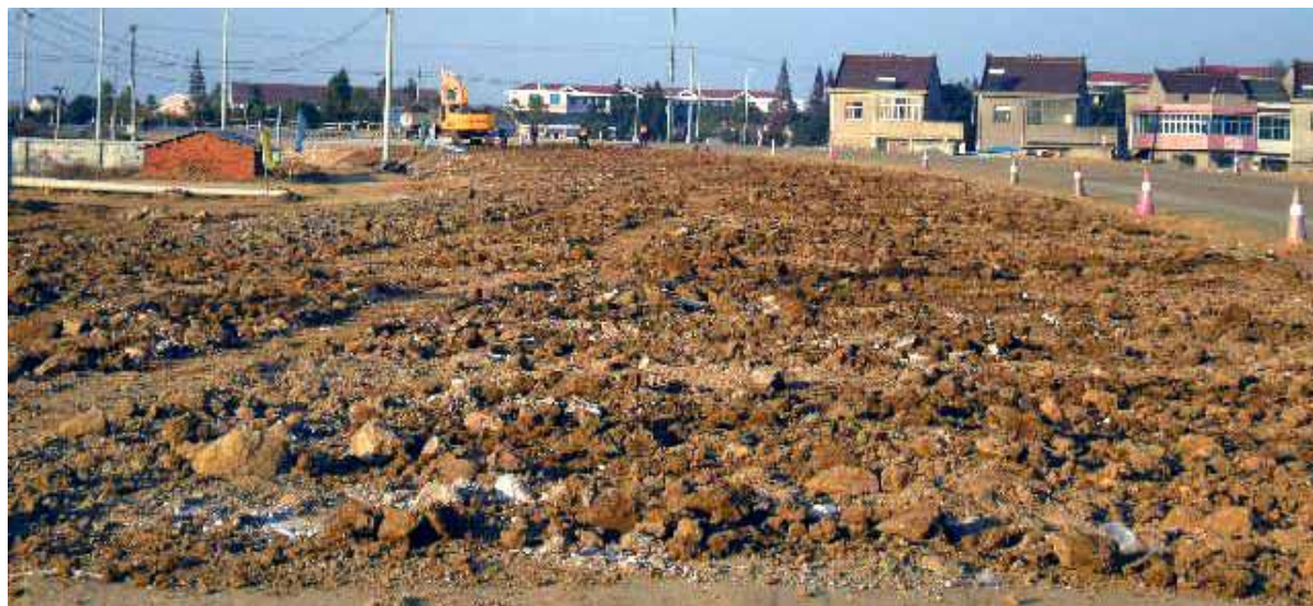
翻松耙平进行地基土的保温防冻
