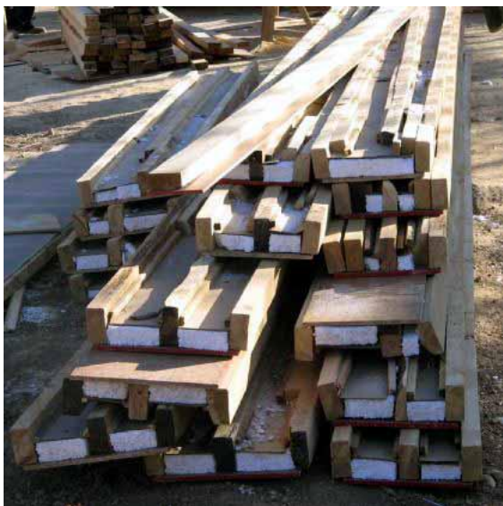
冬期施工的模板保温
