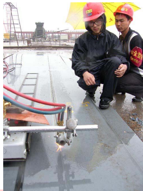
绿火神新型高效焊割燃气 雨中切割钢板
