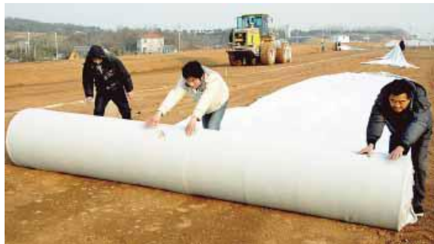
路基覆盖保温材料
