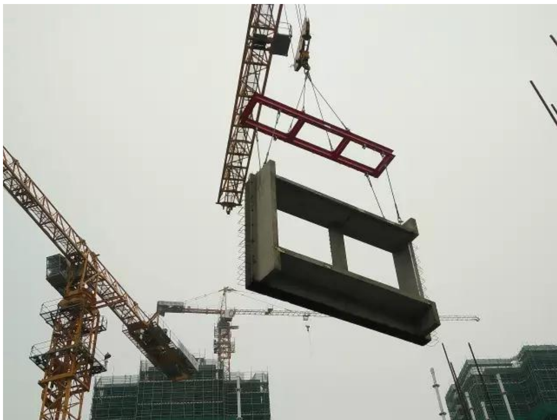
▲ 平衡吊吊装
