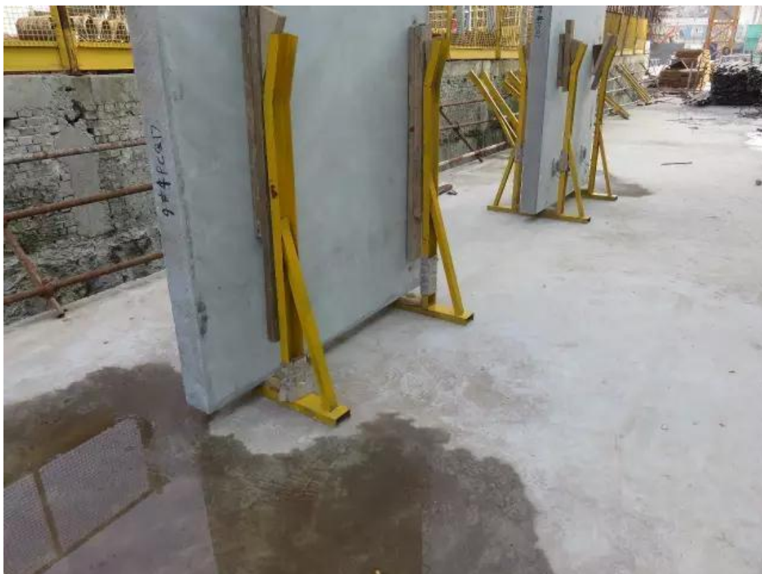
▲ 构件进场后存放
