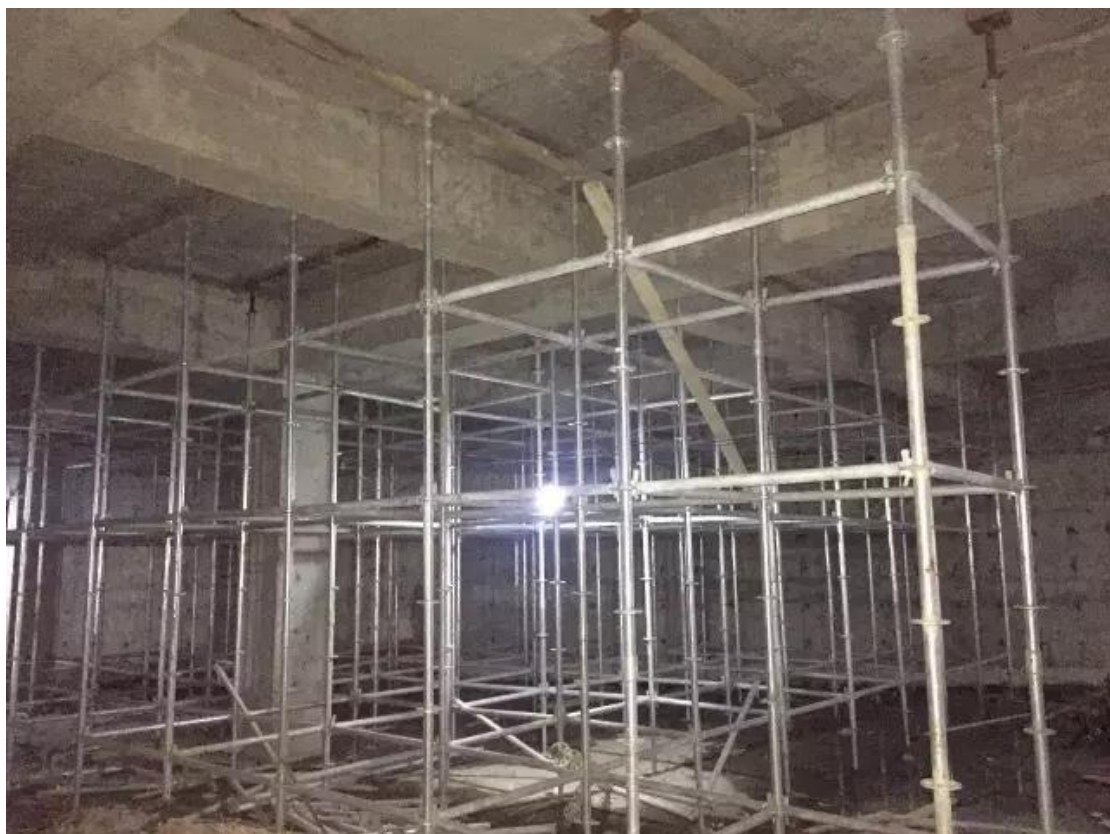
▲ PC 构件行车道顶板下回顶加固
