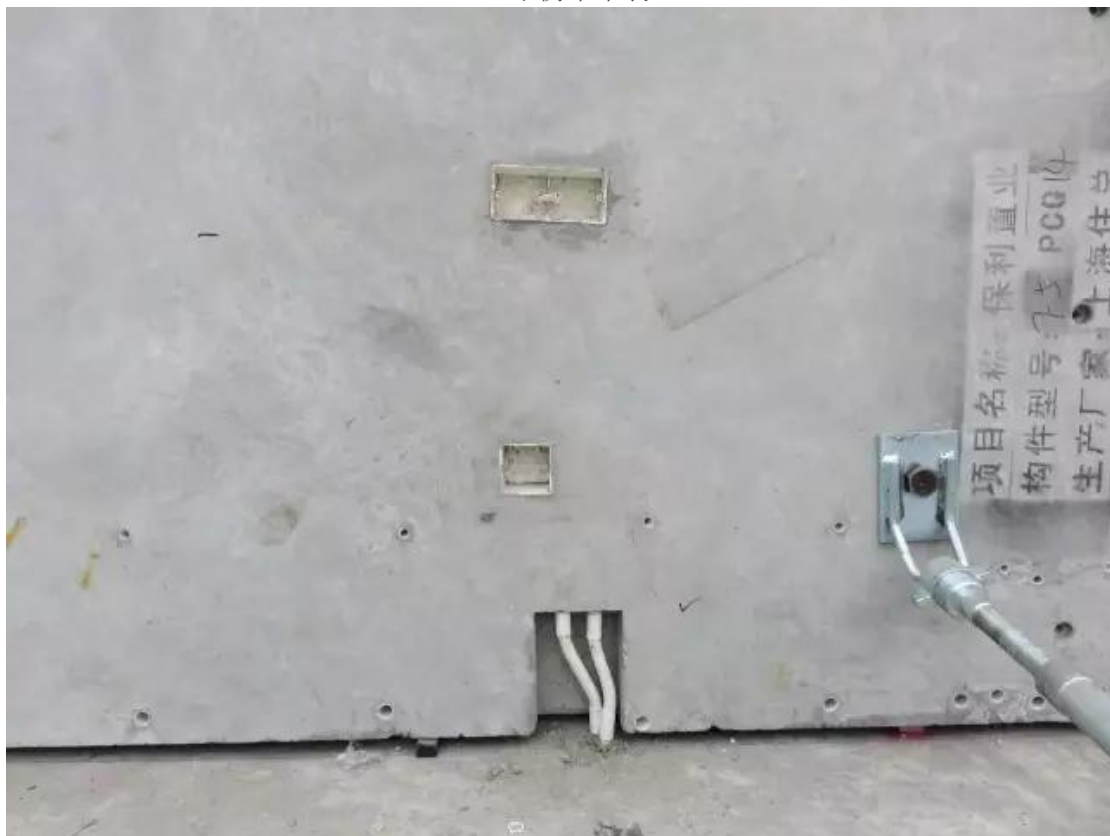
▲ 机电管线连接
