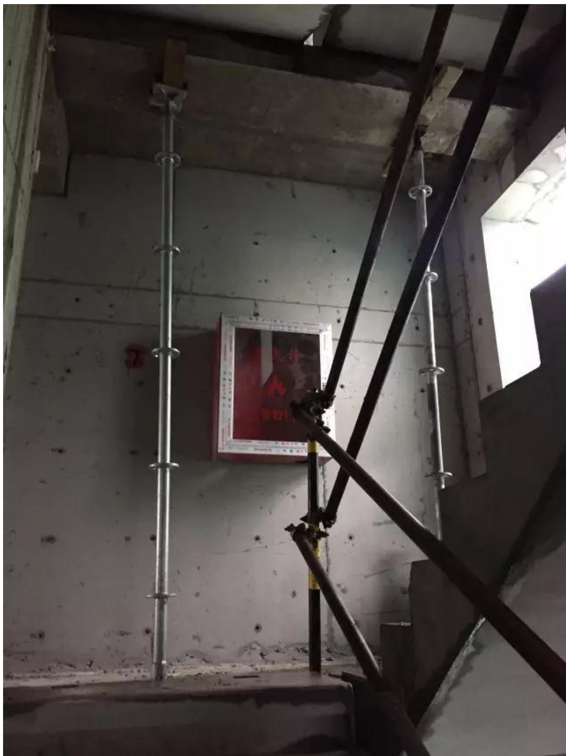
▲ 楼梯承台下支撑加固
