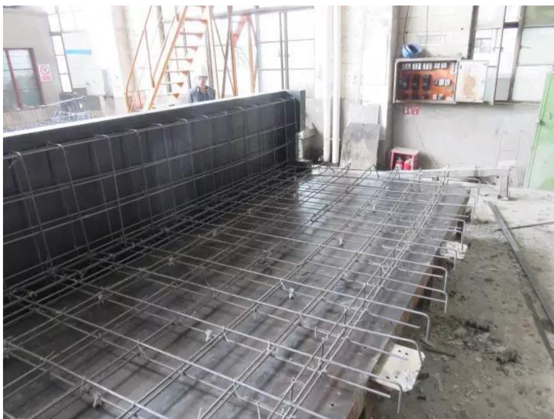
▲ 下沙构件浇筑准备
