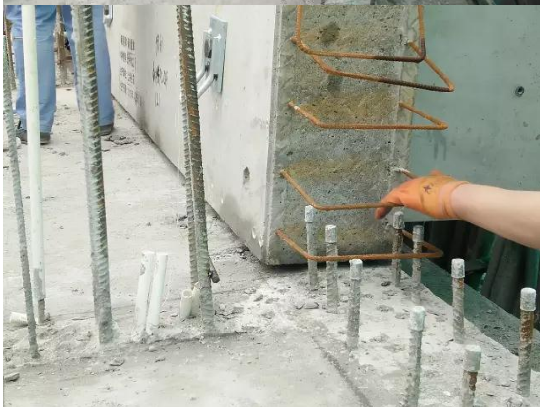
▲ 构件对位安装
