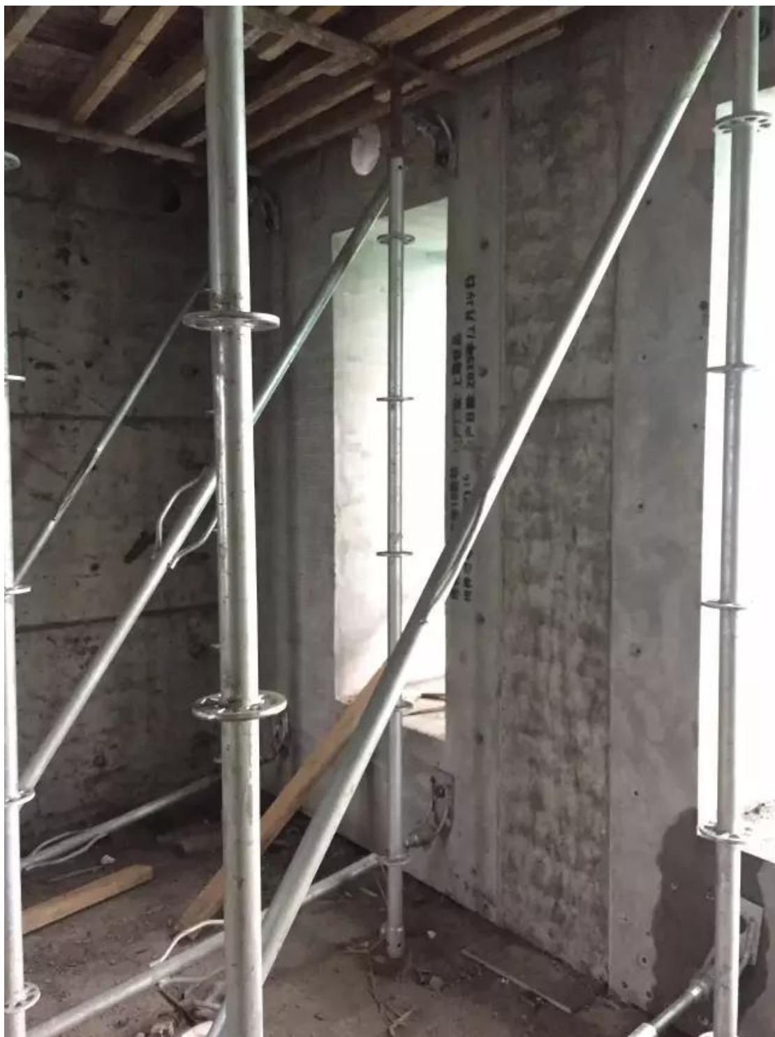
▲ PC 层现浇板回顶支撑
