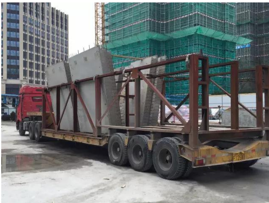
▲ 构件卸车前各项检验
