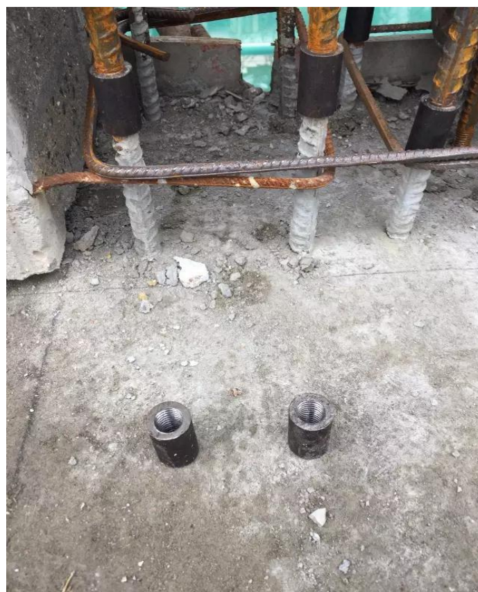
▲ 现浇段钢筋连接套筒
