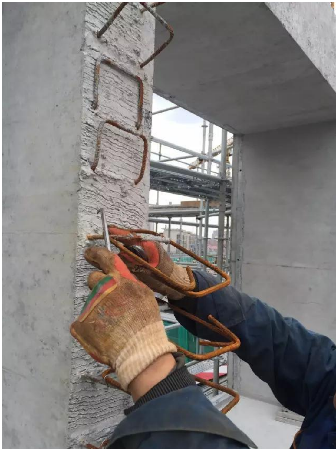
▲ 现浇段箍筋绑扎
