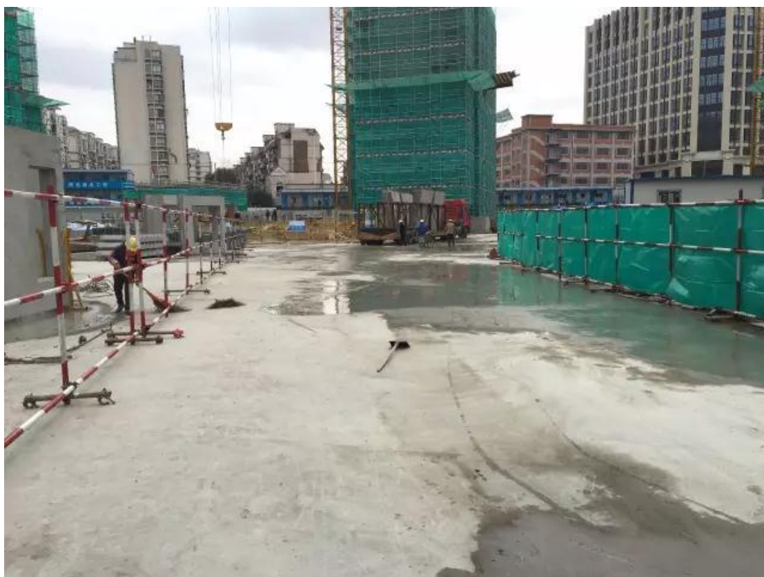
▲ 构件车抵达现场等待卸车
