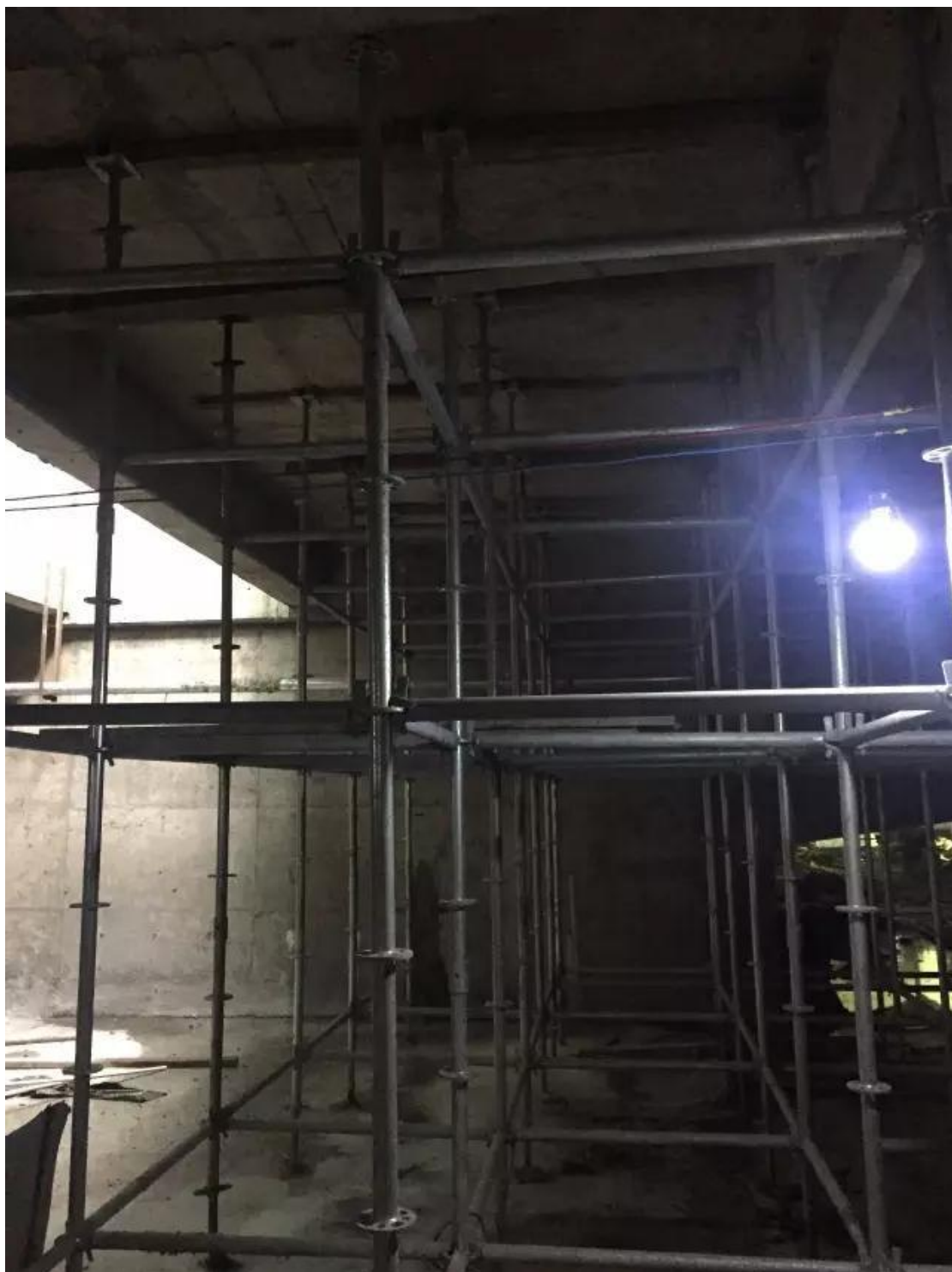
▲ 构件堆场回顶加固
