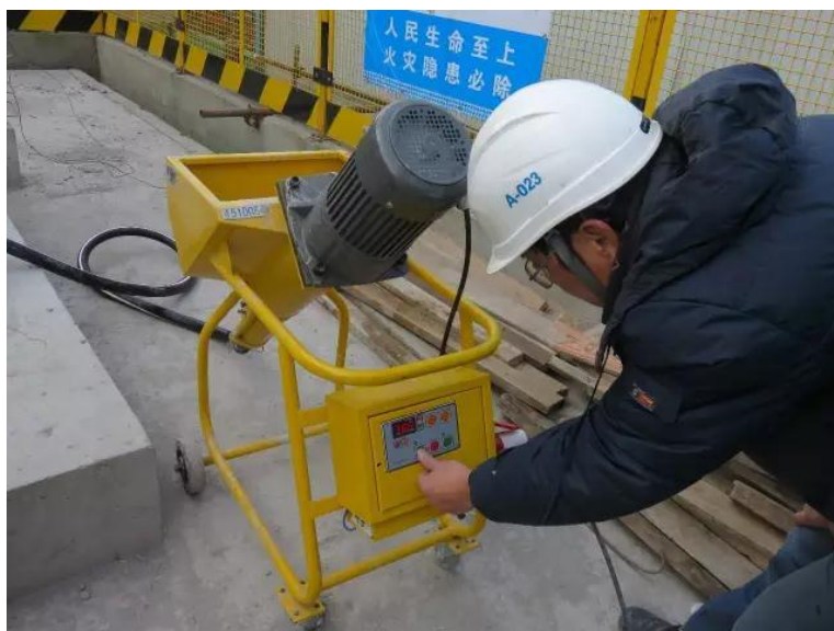
▲ 灌浆机械压力表检查
