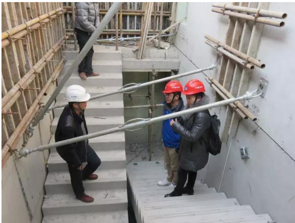
▲ 楼梯处墙板斜撑
