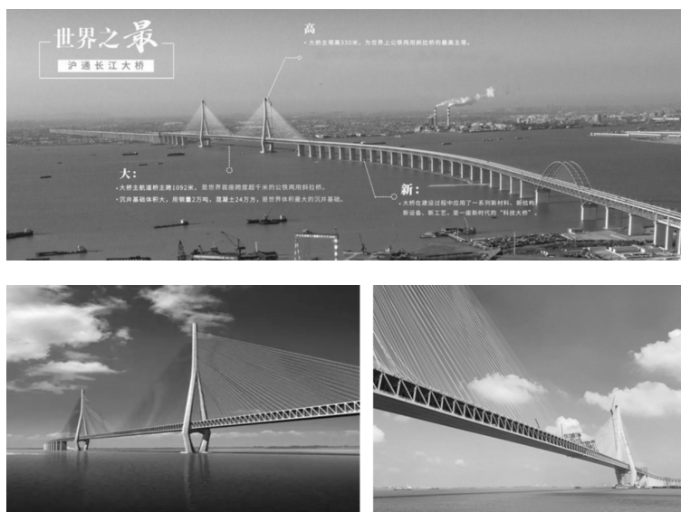
图 3.32 沪苏通长江公路铁路大桥
