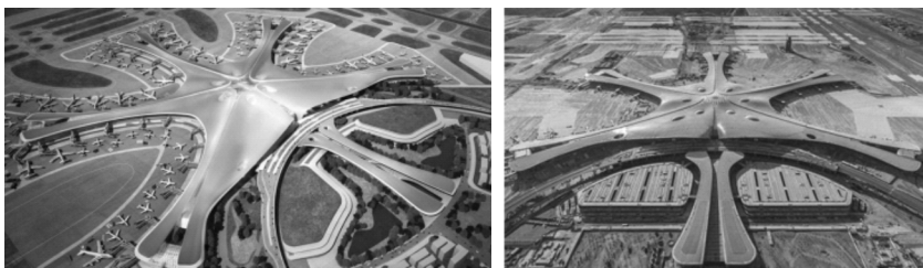
图 3.63 北京大兴国际机场
