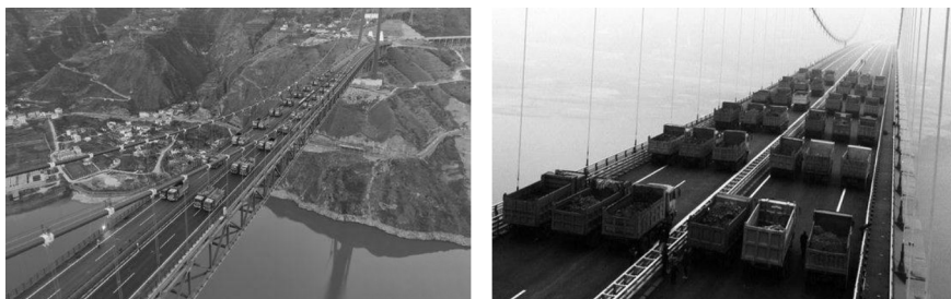
图 3.72 桥梁荷载试验的汽车荷载
