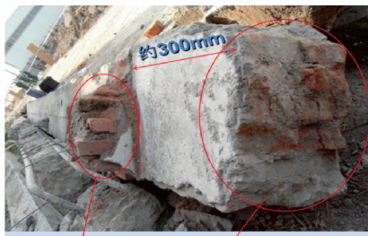
砖柱位置，与现场量测尺寸相符 梁内夹砖且钢筋不连续
