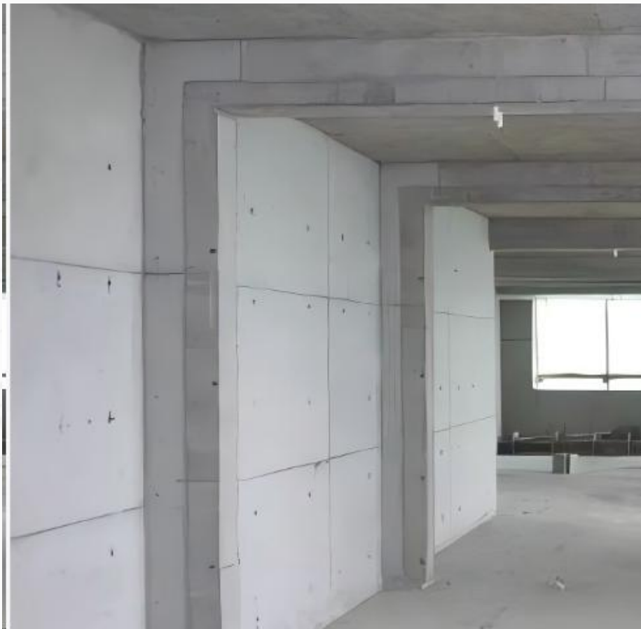
现浇钢筋混凝土墙
