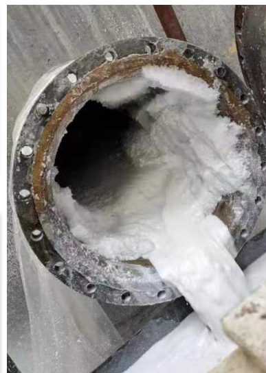
硫酸镁结晶导致管道堵塞
