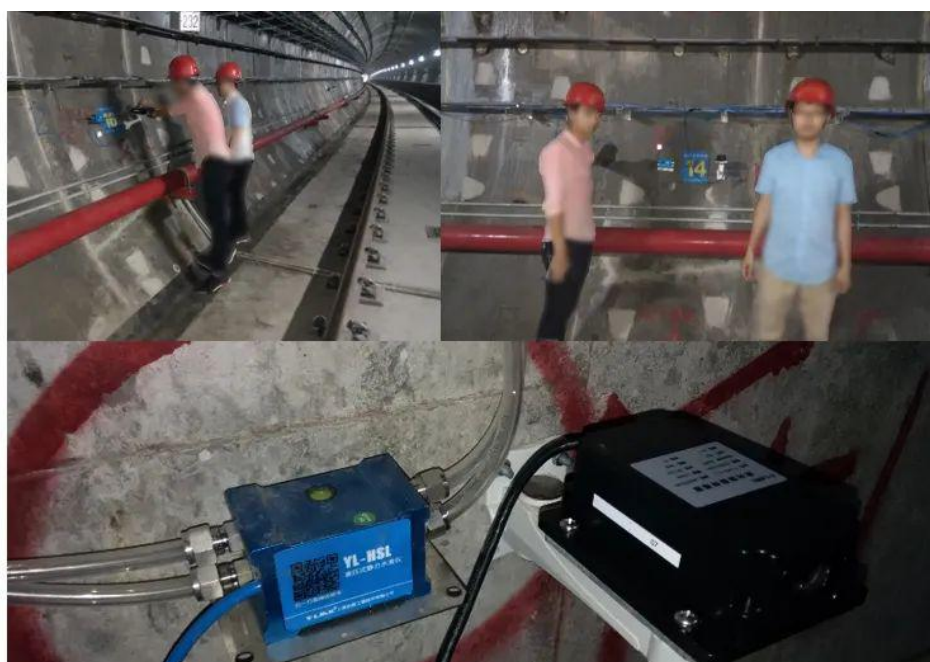
图 5 厦门某地铁隧道变形监测
