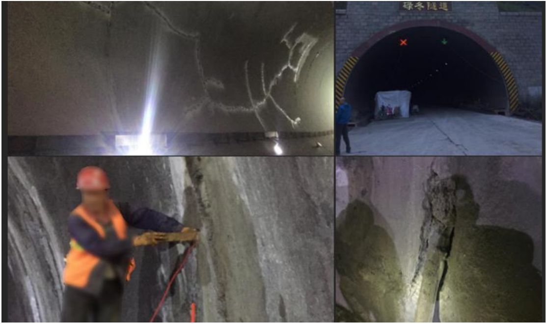
图 6 甘肃某公路隧道渗压监测
