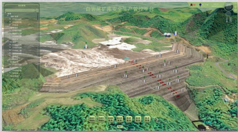
尾矿坝在线监测系统 DM TMS
