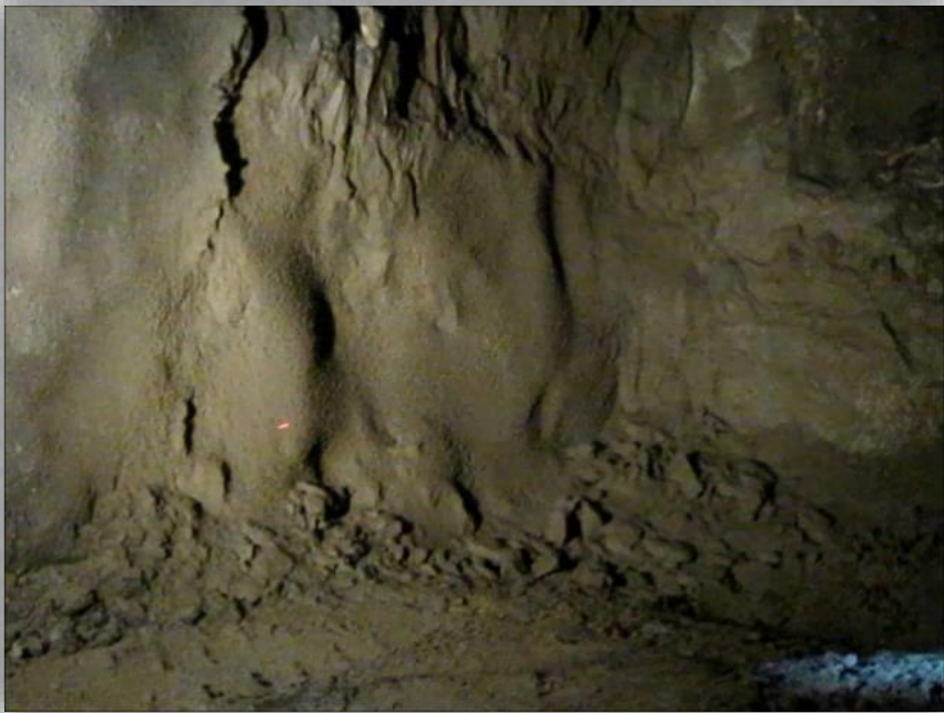
智能化喷混凝土过程
